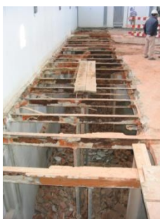
Figura 4.6 – Reconstrução da laje em betão armado no edifício da Baixa Pressão (fonte: Fundação EDP).
