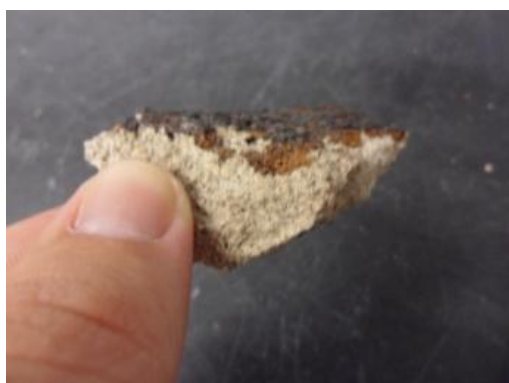
Figura 6.12 - Presença de ferrugem na amostra de argamassa proveniente da corrosão dos perfis metálicos.
