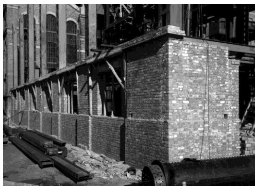
Figura 3.20 – Assentamento da alvenaria no Piso 0 do edifício de AP (fonte: cdme).
