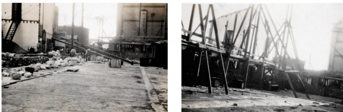
Figura 3.15 – Execução da alvenaria ordinária de pedra. Construção da última nave de BP (fonte: cdme).
