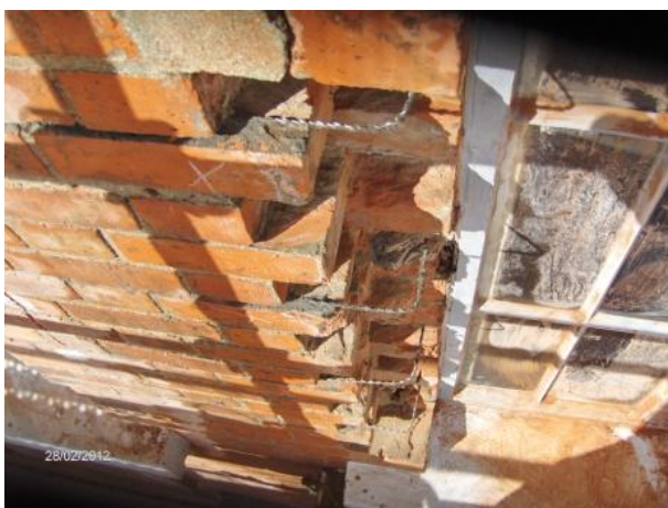
Figura 5.20 – Aplicação da técnica de Crack Stitching . Varão dobrado na extremidade (esquerda) e varão normal (direita) (fonte: STB).
