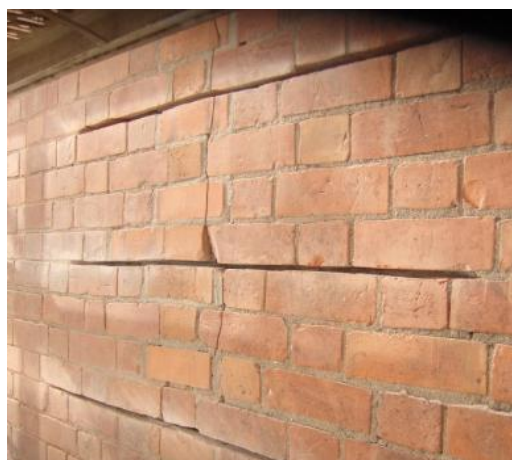
Figura 5.20 – Aplicação da técnica de Crack Stitching . Varão dobrado na extremidade (esquerda) e varão normal (direita) (fonte: STB).
