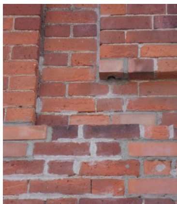
Figura 3.27 – Diversidade de argamassas presentes na fachada Norte do edifício de BP.
