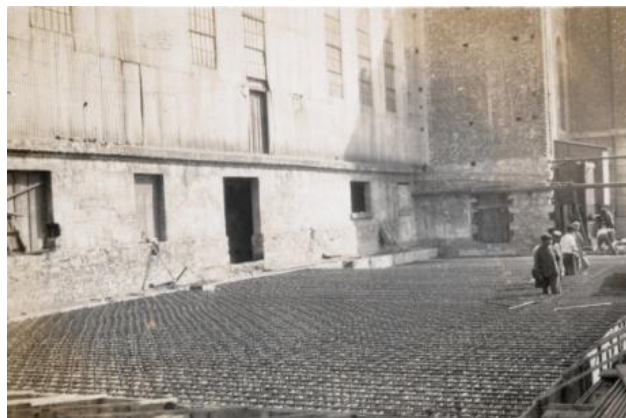
Figura 3.9 – Execução do ensoleiramento geral. Edifício da BP (fonte: cdme).
