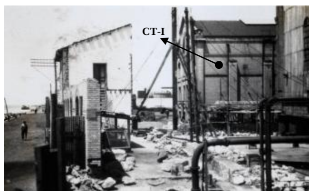
Figura 2.7 – Construção da última nave do edifício das caldeiras de Baixa Pressão (vista SE) (fonte: cdme).
