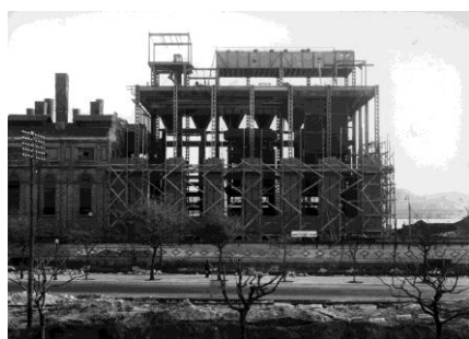
Figura 2.12 – Construção da Central Tejo III (vista N) (fonte: cdme).
