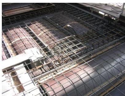
Figura 4.6 – Reconstrução da laje em betão armado no edifício da Baixa Pressão (fonte: Fundação EDP).
