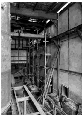
Figura 2.11 – Construção da sala de tratamento de águas (fonte: cdme).
