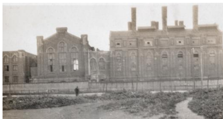
Figura 2.5 – Fachada Norte da CT-II (fonte: cdme).
