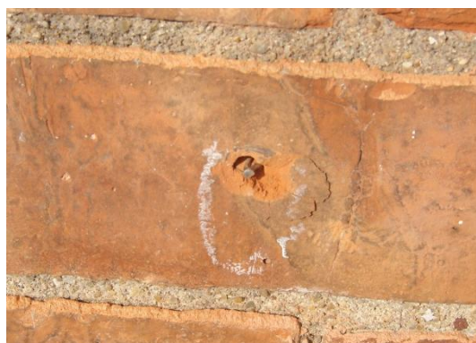
Figura 5.16 - Pormenor da aplicação de DryFix (fonte: STB).
