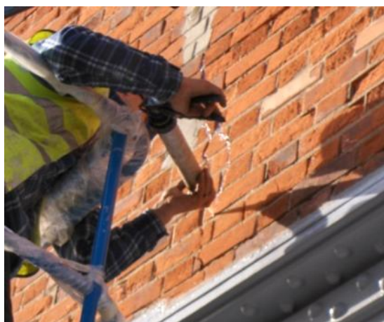
Figura 5.21 – Selagem de fissuras com resina epóxi (fonte: Fundação EDP).
