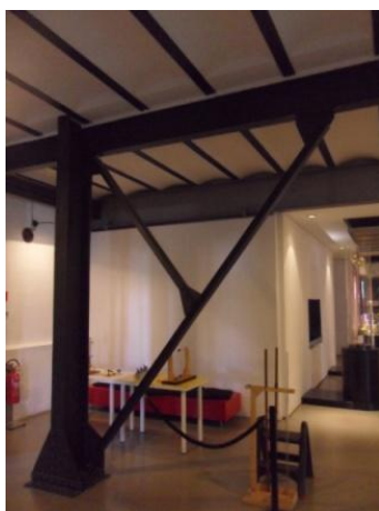
Figura 3.28 – Estrutura metálica da BP.
