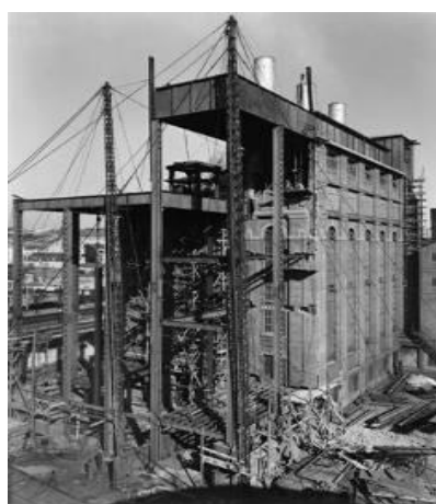
Figura 2.16 – Ampliação do edifício da AP (Vista SW) (fonte: cdme).
