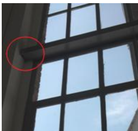
Figura 3.17 – Janelão com caixilharia metálica (visto do interior).
