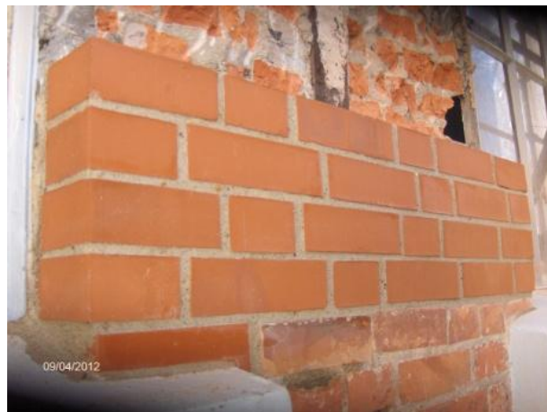
Figura 5.24 - Reconstrução do pano de alvenaria (fonte: STB).
