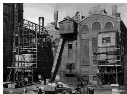
Figura 2.13 – Construção da torre dos Silos misturadores (fonte: cdme).
