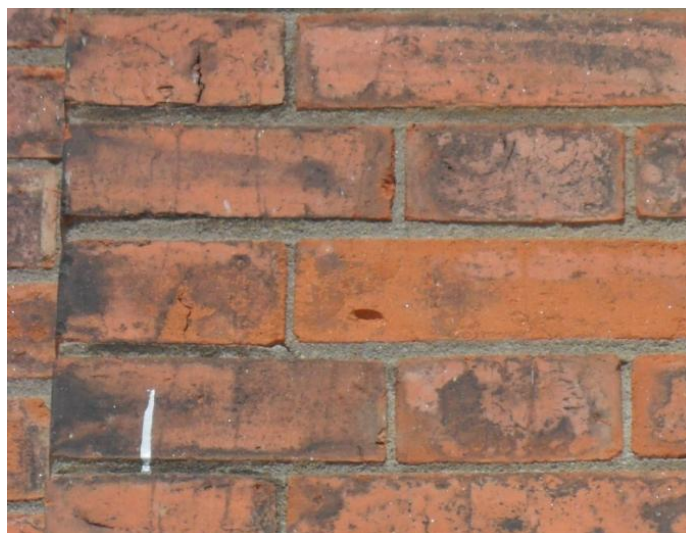
Figura 3.30 – Alvenaria de tijolo na fachada Sul da AP.
