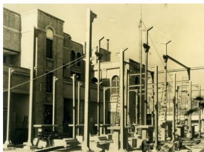
Figura 2.10 – Construção do posto de transformação (vista SE) (fonte: L.Cruz).
