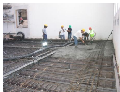
Figura 4.6 – Reconstrução da laje em betão armado no edifício da Baixa Pressão (fonte: Fundação EDP).
