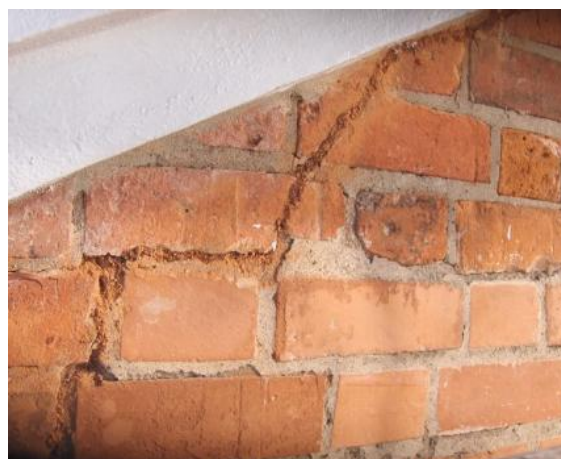
Figura 5.21 – Selagem de fissuras com resina epóxi (fonte: Fundação EDP).
