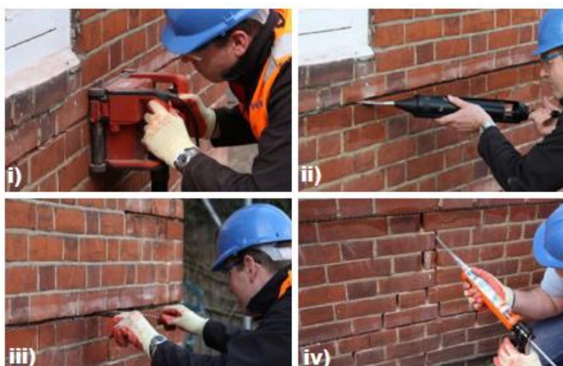
Figura 5.17 – Procedimento na aplicação de Crack Stitching [8].
