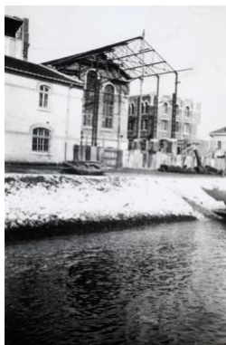
Figura 2.8 – Ampliação da Sala das Máquinas (vista SW) (fonte: cdme).
