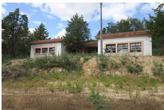
Fig. 15 | Fachada principal da escola primária e pré-escolar de Rochel, vista inferior.
