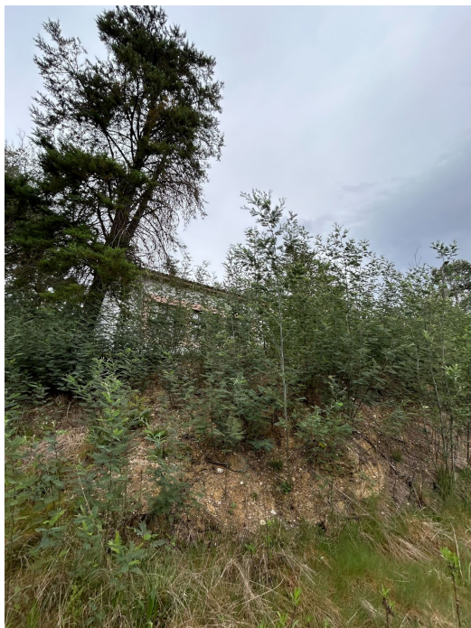
Fig. 25 | Vista frontal da Escola Primária e Pré-Escolar de Rochel, onde se destaca a presença de vegetação.
