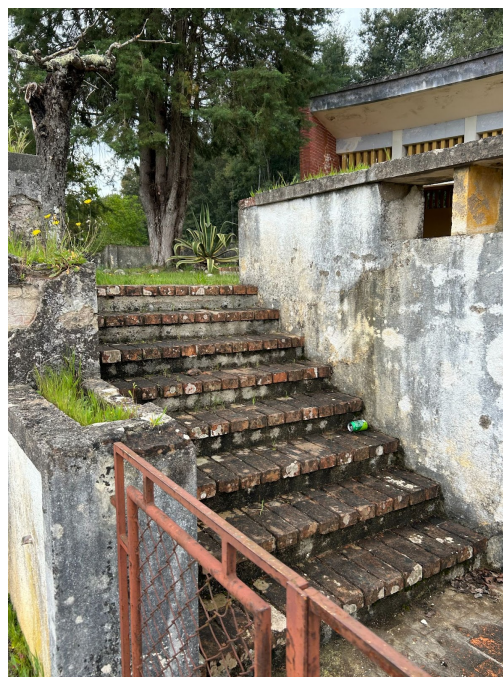
Fig. 20 | Segundo lanço de escadas de acesso ao terreno da Escola Primária de Sarnadela.
