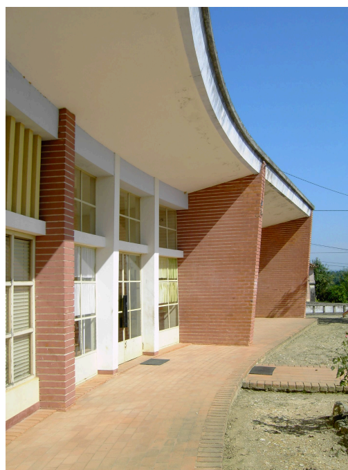
Fig. 32 | Vista da fachada principal, caracterizada por amplas superfícies envidraçadas.
