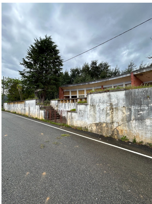
Fig. 21 | Vista frontal do terreno da escola, evidenciando a ausência de zona pedonal segura. Vias pavimentadas.
