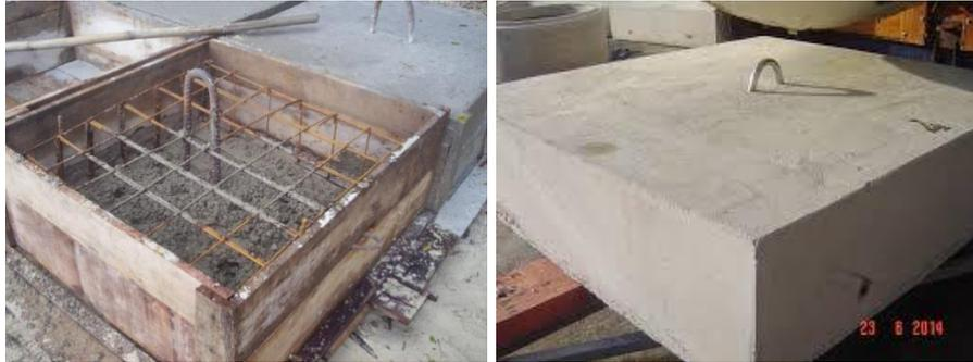
Ilustração de poitas em concreto armado.
