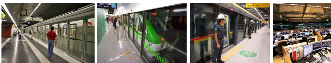
191. Instalaciones de seguridad. Metro de Barcelona.
