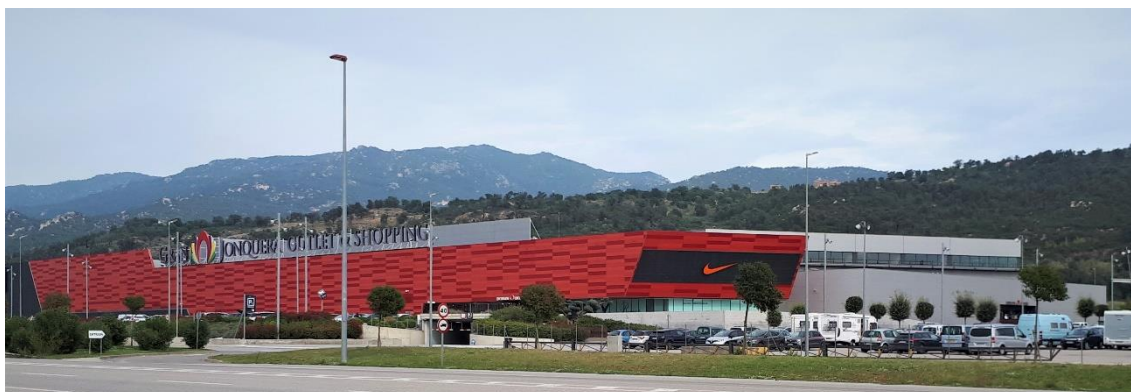
202. La Jonquera, Girona. Centro comercial Gran Jonquera. La autorización para su apertura estuvo condicionada a la construcción de un gran aparcamiento en superficie y subterráneo (2019). Foto del autor.
