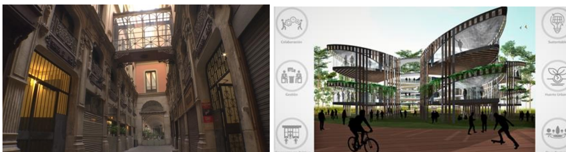
418. Barcelona. Pasaje Bacardí, El ocaso de las Galerías Comerciales (2018). TV3.
