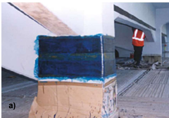
Figura 3 – Aplicações de FRP como reparação ou reforço: (a) mantas de CFRP utilizadas para reforço do Viaduto Duarte Pacheco; (b) instalação de tabuleiro totalmente em FRP, adaptado de [3].
