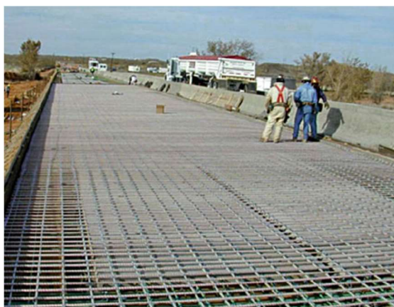
Figura 2 – Preparação de tabuleiro de ponte em betão reforçado com varões de GFRP, no Canadá, adaptado de [3].
