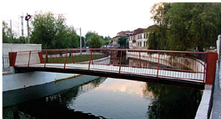
Figura 4 – Ponte pedonal híbrida em aço/GFRP em Viseu, Portugal, adaptado de [3].
