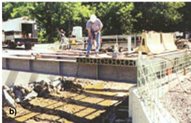
Figura 3 – Aplicações de FRP como reparação ou reforço: (a) mantas de CFRP utilizadas para reforço do Viaduto Duarte Pacheco; (b) instalação de tabuleiro totalmente em FRP, adaptado de [3].
