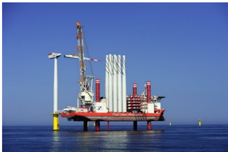
Figura 2.15 – Processo de instalação de uma turbina suportada por uma mono-estaca [48]
