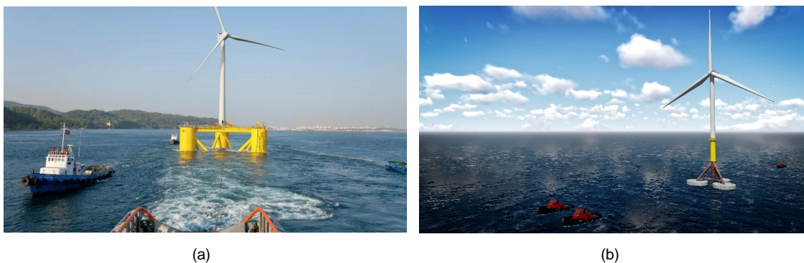
Figura 2.16 – (a) WindFloat durante o transporte [49]; (b) Demogravi3 durante o transporte [50]
