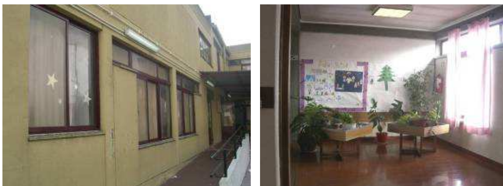
Figura 5.26 - Escola n.º 45: acesso Poente e átrio de acesso às salas de aulas no 2º piso
