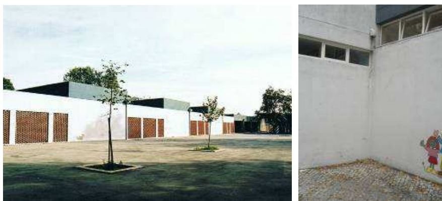
Figura 5.19 - Alçado Poente: Vista do recreio e blocos de salas de aulas alternados com zonas de pátios interiores (delimitados por elementos cerâmicos) (esq.); pormenor do pátio interior (dta.)
