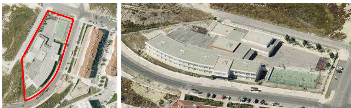
Figura 5.47 - Localização e delimitação da Escola de São Bartolomeu (fonte: Google Earth, 2008)
