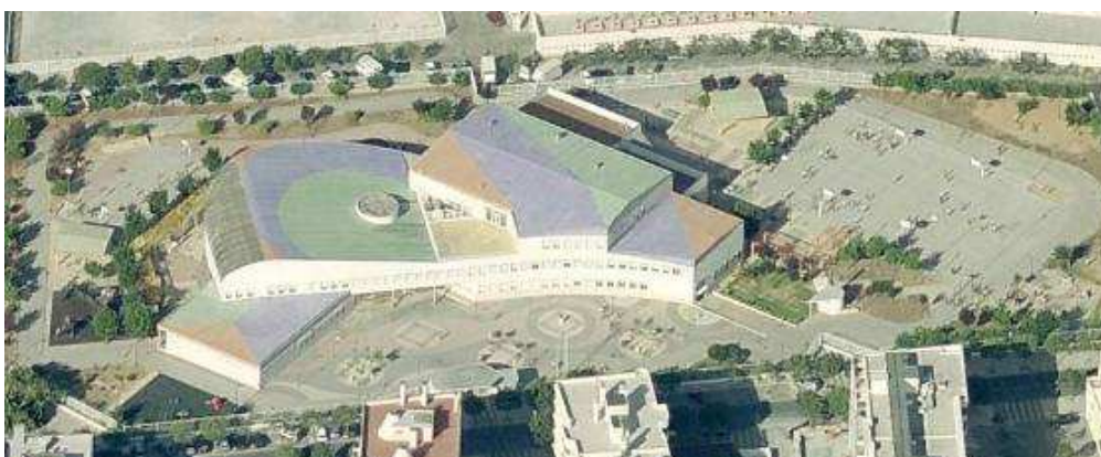
Figura 5.10 - Vista geral da escola integrada Vasco da Gama (freguesia de Santa Maria dos Olivais).
