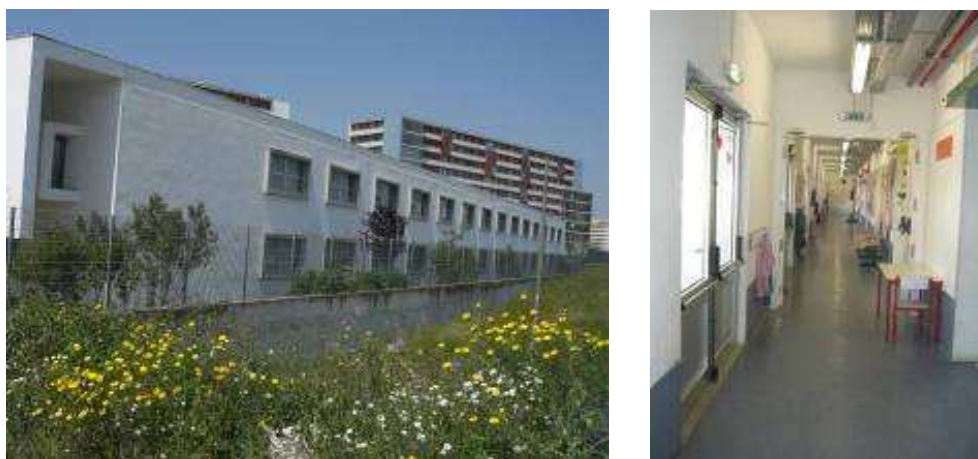
Figura 5.43 - Escola n.º 34: fachada Nascente do bloco de salas de aula (esq.); vista do corredor de circulação / distribuição de acesso às salas de aulas (dta.)
