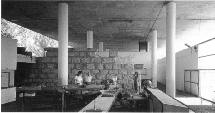
**1** Muro transversal de granito entre as duas zonas
