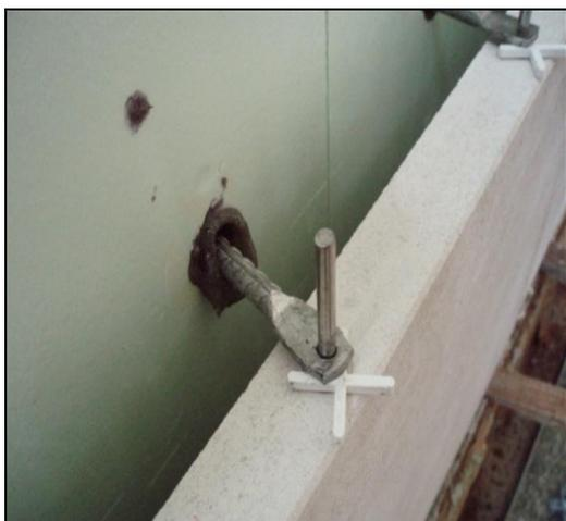
Figura 64 – Pormenor das pedras ligadas aos gatos de fixação com espaçador e pino.
