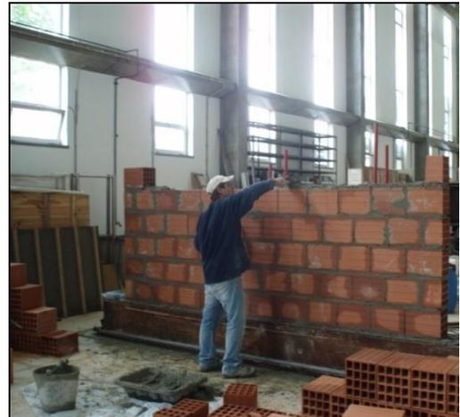
Figura 52 – Construção da parede
