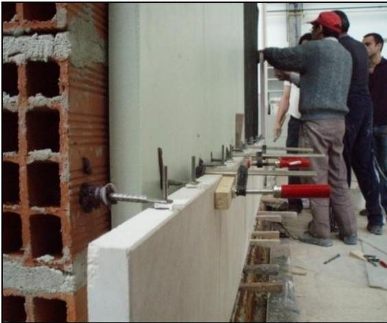
Figura 55 – Assentamento das pedras da fachada ventilada.
