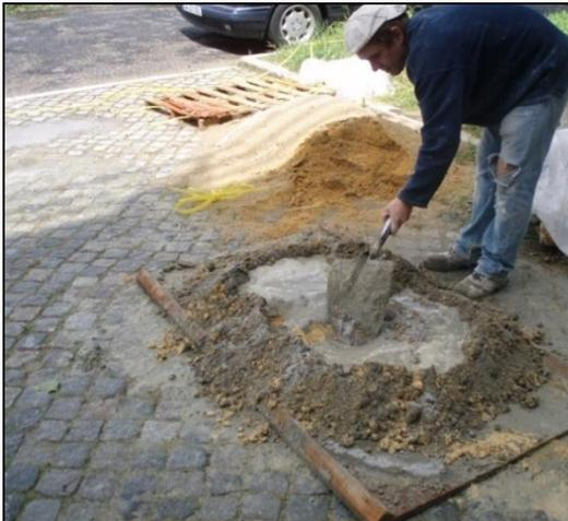
Figura 51 – Preparação da argamassa para a construção da parede.
