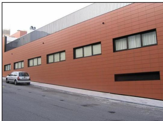
Figura 7 - Revestimento em cerâmico ( [www.Arquiwall.pt](http://www.Arquiwall.pt), 2009).
