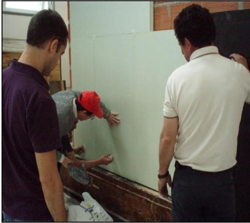
Figura 73 – Implantação do isolamento de XPS e lâ-de-rocha.
