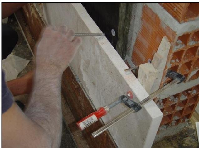
Figura 61 - Introdução do gato na camisa para fixação dos painéis de revestimento.
