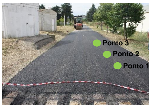
Figura 8.40 – Localização esquemática dos pontos para avaliação do coeficiente de atrito e profundidade média da textura no trecho experimental no LNEC
