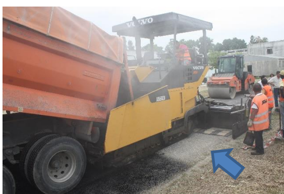
Figura 6.10 – Zona do trecho experimental sem aplicação de rega de colagem
