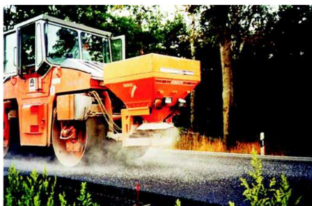
Figura 3.16 – Equipamento e espalhamento de agregados de pequena dimensão (Drieschner & Schaefer, 2005)
