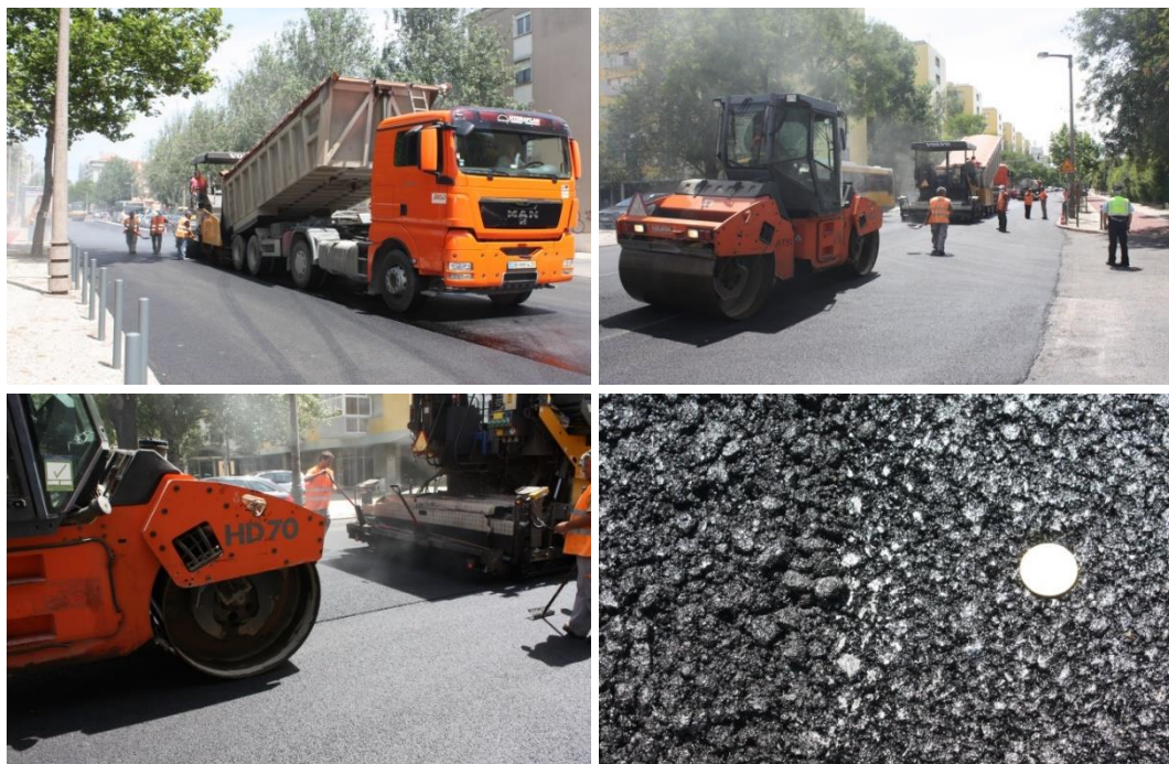
Figura 6.11 – Aplicação e compactação da mistura SMA 12 com fibras celulósicas na Avenida do Brasil
