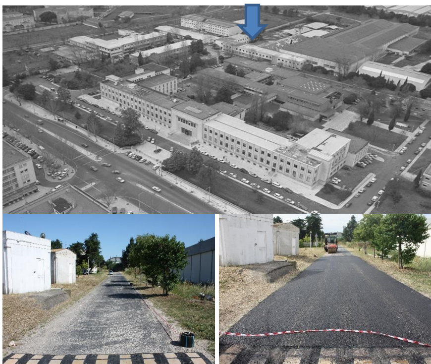
Figura 6.9 – Localização e vista geral do trecho experimental realizado no LNEC com a mistura SMA 12 com fibras celulósicas
