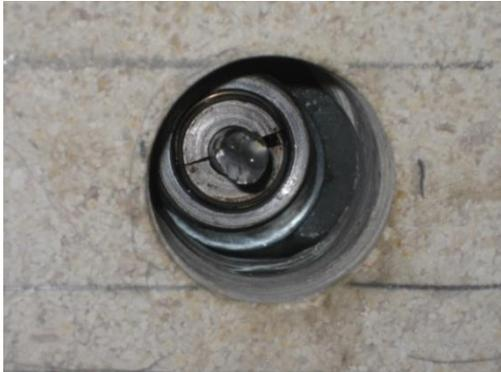
Figura 2-22 - Ancoragem passiva oculta na placa de fecho (Fonte: retirado de [14]).
