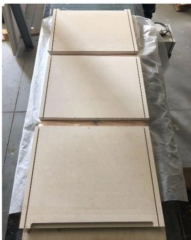
Figura 5-15 - Colocação das placas do pano de pedra inferior.
