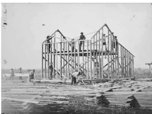
Figura 2-3 - Sistema construtivo *balloon frame*
