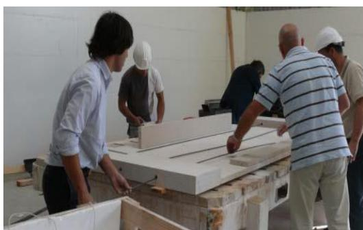
Figura 2-18 - Introdução dos varões de aço (Fonte: retirado de [14]).
