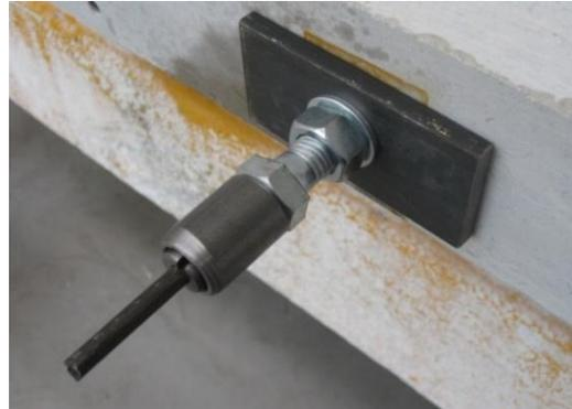
Figura 2-23 - Ancoragem ativa a atuar sobre a placa de fecho (Fonte: retirado de [14]).
