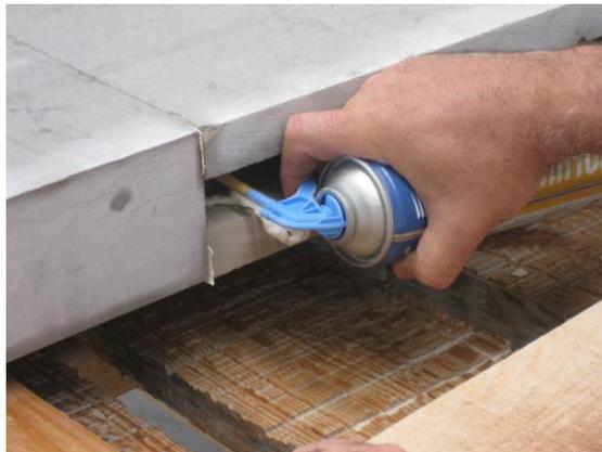
Figura 2-24 - Injeção da camada de isolamento térmico e acústico (Fonte: retirado de [14]).
