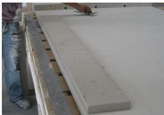
Figura 2-17 - Introdução das placas de pedra junto às extremidades longitudinais (Fonte: retirado de [14]).
