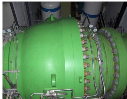
**Fotografias 9 e 10** – À esquerda, o eixo de uma das turbinas-bombas e à direita a válvula esférica da mesma.
