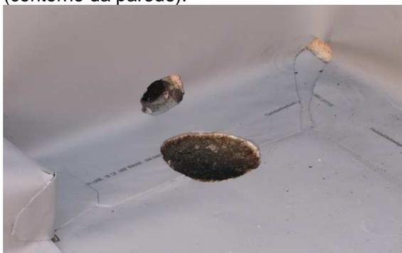
Figura 6.8 – Singularidade da cobertura antes de finalizada (zona do tubo de queda).
