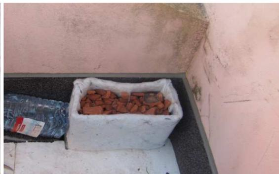
Figura 6.21 - Instalação do dreno.
