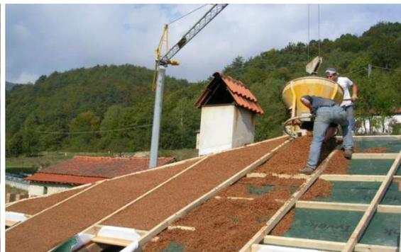
Figura 3.13 – Aplicação de aglomerado de cortiça na forma granular (Artimestieri Bioedilizia, 2010).
