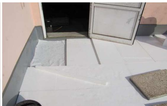
Figura 6.15 – Zona adjacente à porta de acesso com placas de 5cm de espessura.
