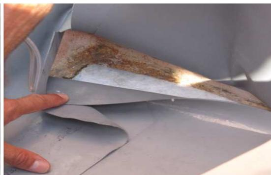
Figura 6.5 – Pormenor construtivo de um canto da cobertura antes da membrana ser colada.
