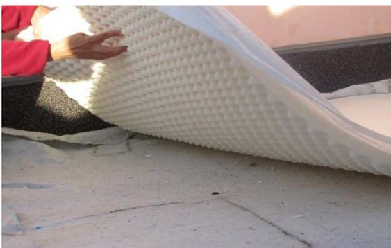
Figura 6.22 – Instalação dos rolos de espuma elástica de poliuretano de alvéolos fissurados.
