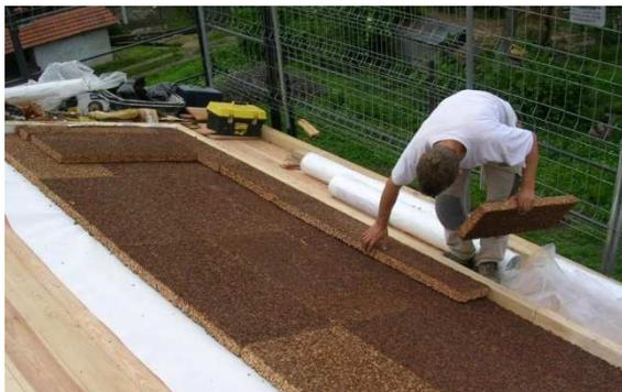
Figura 3.12 – Aplicação de placas de isolamento térmico à base de cortiça (Artimestieri Bioedilizia, 2010).
