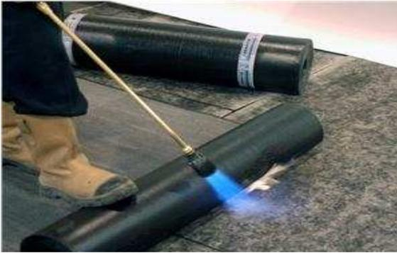
Figura 3.4 – Aplicação das membranas betuminosas a quente (WMroofing, 2009).
