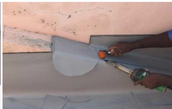
Figura 3.7 – Aplicação do PVC na cobertura do caso de estudo recorrendo a ar quente.
