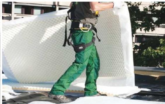
Figura 3.15 – Instalação de camadas de poliuretano expandido (The VYDRO Effect, 2010).
