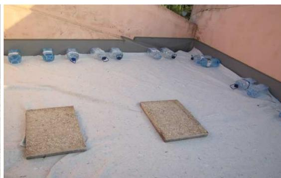
Figura 6.17 – Cobertura com o isolamento térmico e manta geotêxtil.
