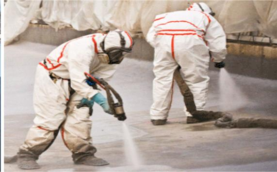
Figura 3.9 – Aplicação de membranas de impermeabilização líquidas (Cesel - Eclaws).
