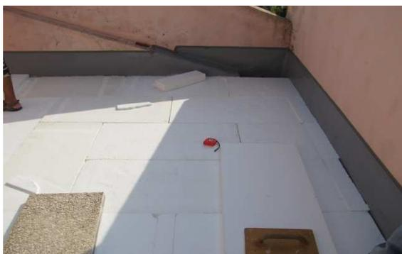
Figura 6.14 – Placas de isolamento térmico com 10cm de espessura.
