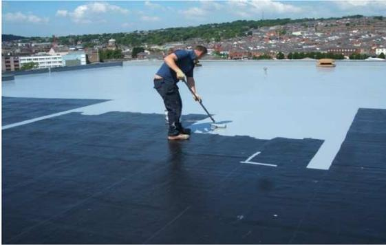
Figura 3.8 – Aplicação de membranas de impermeabilização líquidas (Dewhurst Industrial).
