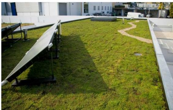
Figura 2.15 - Cobertura extensiva de sedum numa habitação particular em Vila Nova de Gaia (NEOTURF).
