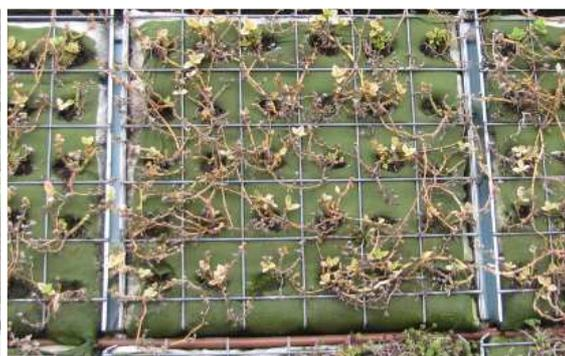
Figura 3.28 – Painéis esponjosos instalados na fachada das Natura Towers, Portugal.
