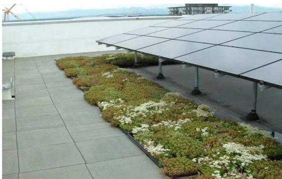
Figura 3.24 – Sistema modular da greengrid (Green Grid).
