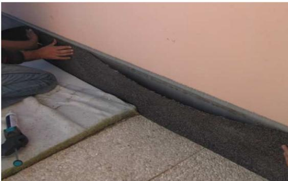
Figura 6.18 - Aplicação do revestimento na membrana da parede.
