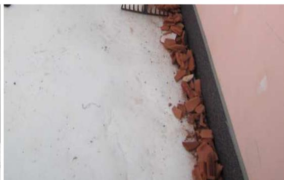
Figura 6.26 – Material grosseiro na zona de escoamento da cobertura que dirige a água para o dreno.
