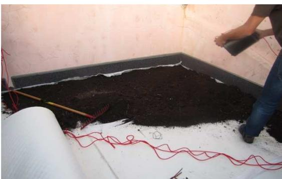
Figura 6.25 – 2ª equipa a colocar o substrato na cobertura.
