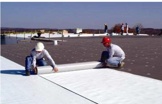
Figura 3.6 – Aplicação dos rolos de membranas “single-ply” (Leva, 2012).
