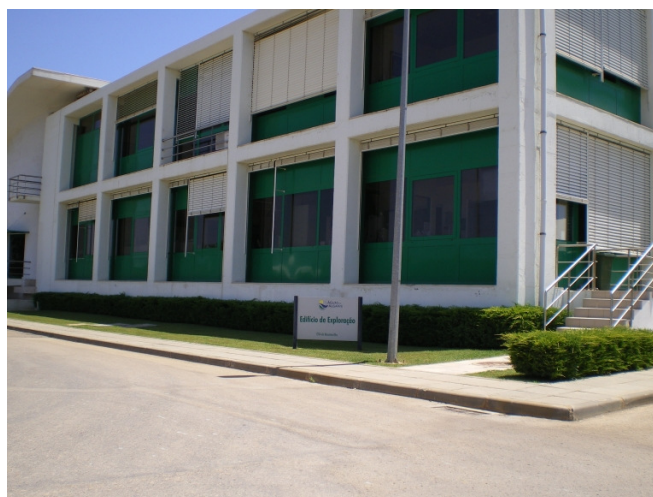
Figura A5.1. 6 - ETA de Alcantarilha – Laboratórios
