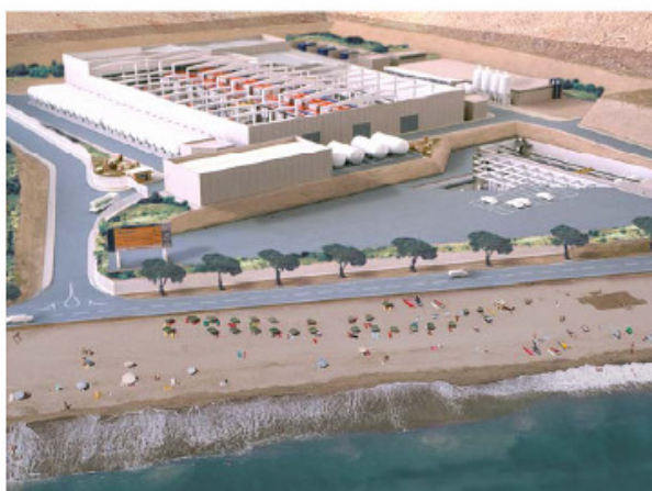
Figura 17 – Instalação de dessalinização Carboneras, em Almeiria. Com capacidade de produção de 120 000 m 3 /dia (Hidroprojecto, 2005)
