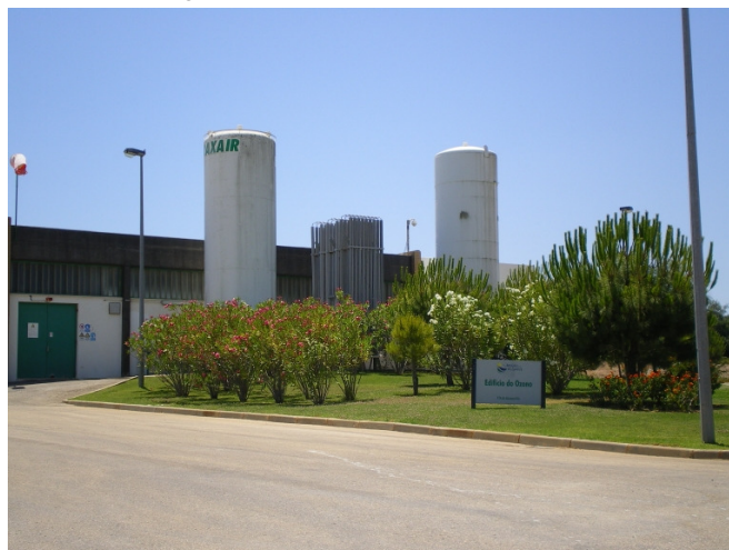
Figura A5.1. 5 - ETA de Alcantarilha - Edifício do Ozono
