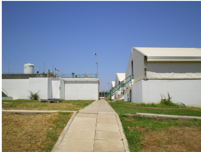
Figura A5.1. 3 - ETA de Alcantarilha
