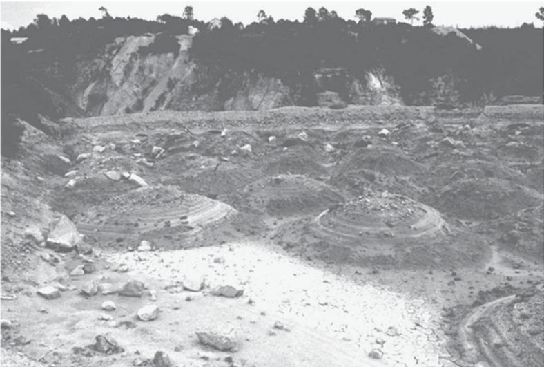
Figura 2. Vista da área do céu-aberto da mina da Cunha Baixa [a], onde ocorreu a lixiviação ácida em pilha do minério pobre [b] (fotos de 1990 gentilmente cedidas pela ENU, S.A.).
