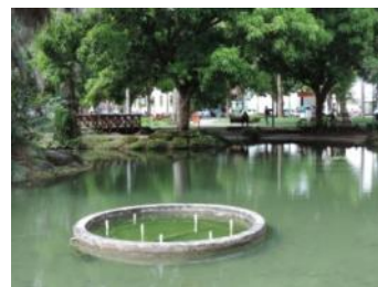
Fig. VI.81 Chafarizes avariados em 2015.
