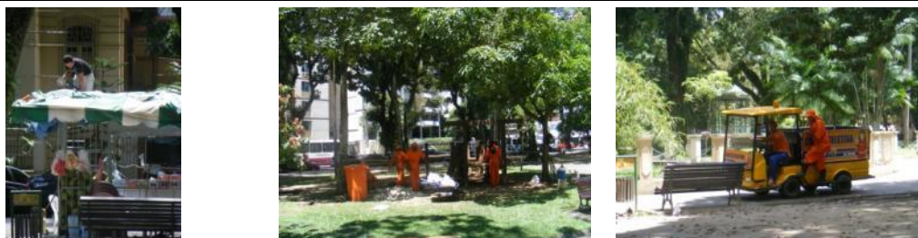
Fig. VI.83 Uso de serra elétrica no reparo de tenda (esquerda), reforma do parque infantil (centro) e carro elétrico de recolha de resíduos sólidos (direita).
