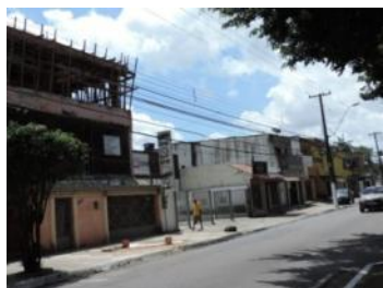
Acréscimo de pisos na Av. Rômulo Maiorana
