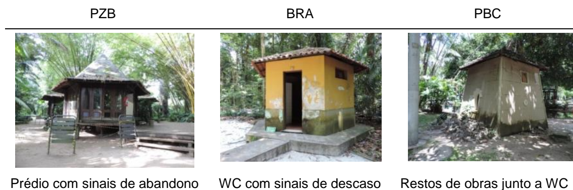
Fig. VI.50 Marcas de negligência nos parques brasileiros.
