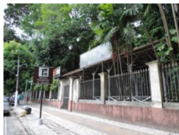
Av. Magalhães Barata (muro com grade)
