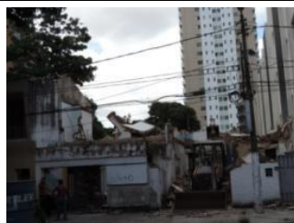
Fig. VI.66 Demolição na Tv. Nove de Janeiro.
