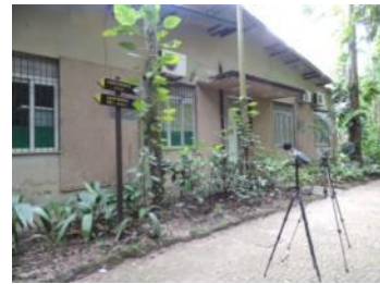
Fig. VI.64 Prédio da CMU, fundos para a Av. A. Cacela.
