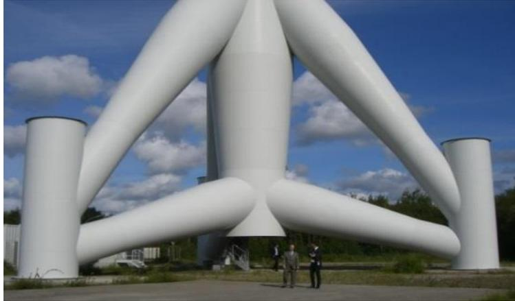
Figura 9 – Fundação *tripod* [26].
