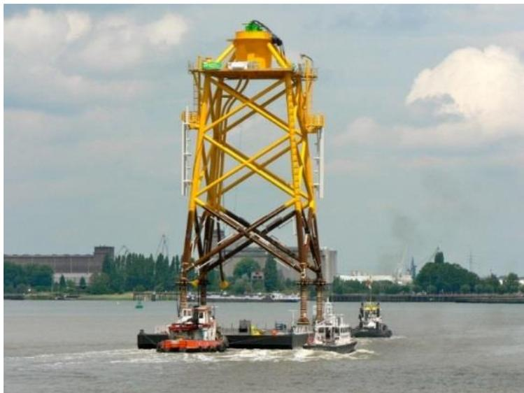
Figura 10 – Fundação *Jacket*, aquando do seu transporte para o local de utilização [27].
