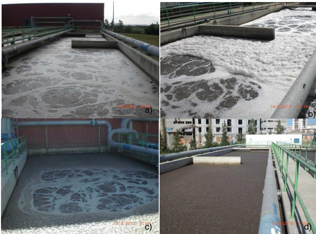
**Figura 28-** Representação da quantidade de espuma nos TAMs: a) +, b) ++, c) +++ e d)++++.
