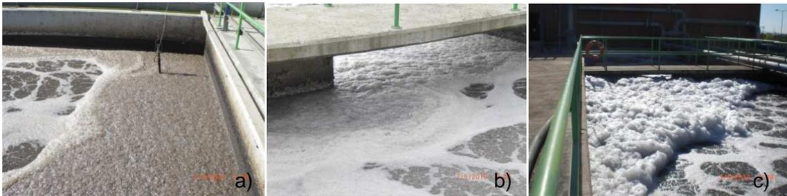
**Figura 27-** Representação da cor da espuma nos TAMs: a) A, b) C e c) E. Quando existem simultaneamente  $A+C=B$  e  $C+E=D$ .
