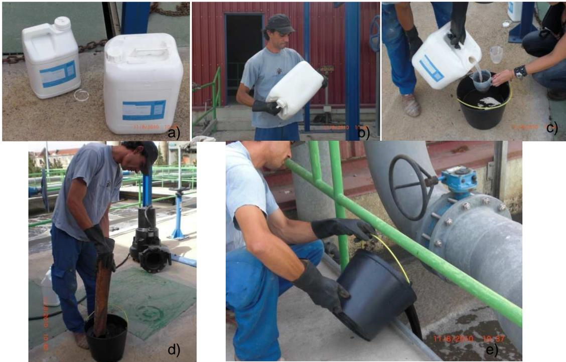
**Figura 18-** Aplicação do anti-espuma e biodigestor: a) Embalagens, b) Agitação, c) dosagem do produto, d) Mistura com água do tanque, e) Introdução do produto no tanque.
