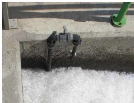
**Figura 24-** “Purga” do arejador para remoção de água condensada na linha de arejamento.
