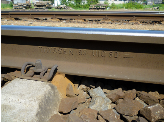
Figura 2.6: Carril UIC60 (Szerkesztő, 2010; UIC60, 2013).
