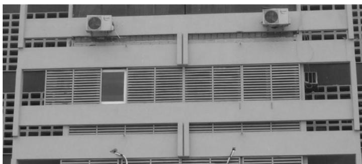
As grelhas em betão colocadas em frente às janelas do quarto protegem a divisão da incidência directa do sol e permitem a abertura das janelas, o que facilita a circulação de ar no interior.
