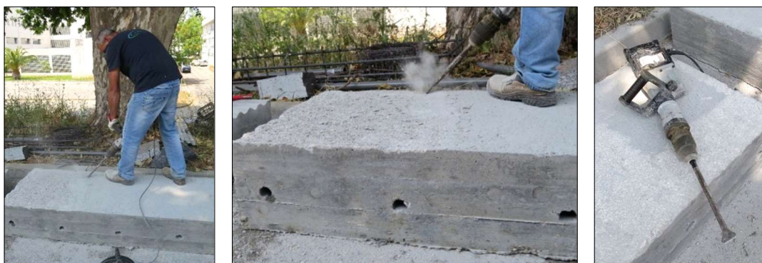
Figura 6.30 – Aplicação do tratamento com martelo pneumático na superfície do tipo SMP adotada nos ensaios de corte longitudinal da série HICM.
