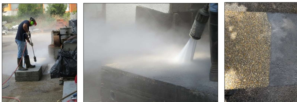
Figura 6.31 – Aplicação de hidrodecapagem na superfície do tipo SHD adotada nos ensaios de corte longitudinal da série HICM e comparação com superfície não tratada.
