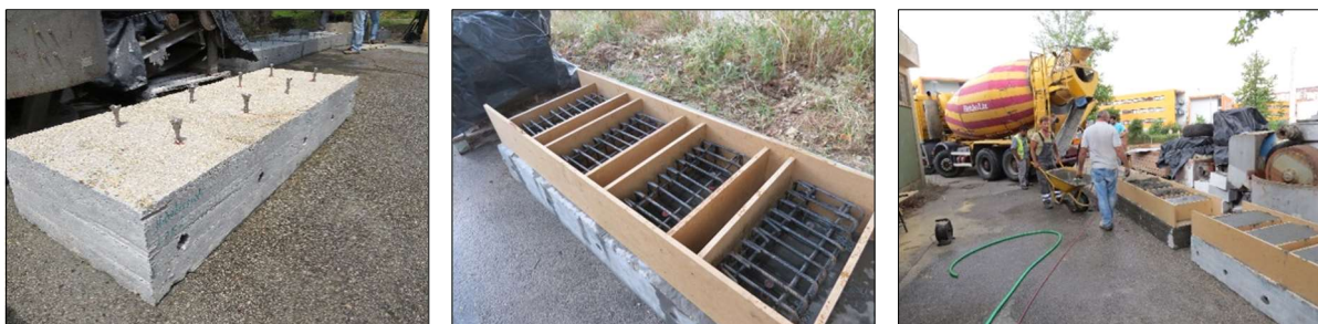
Figura 6.36 – Aplicação dos conectores, preparação e betonagem dos blocos de betão para execução dos ensaios de corte longitudinal da série HICM.
