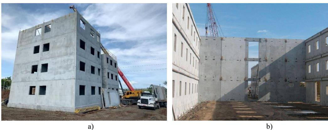
Figura 5 – Estruturas de paredes resistentes pré-fabricadas: a) Edifício em Santa Catarina (Brasil) [14]; b) Edifício nos Estados Unidos [15].
