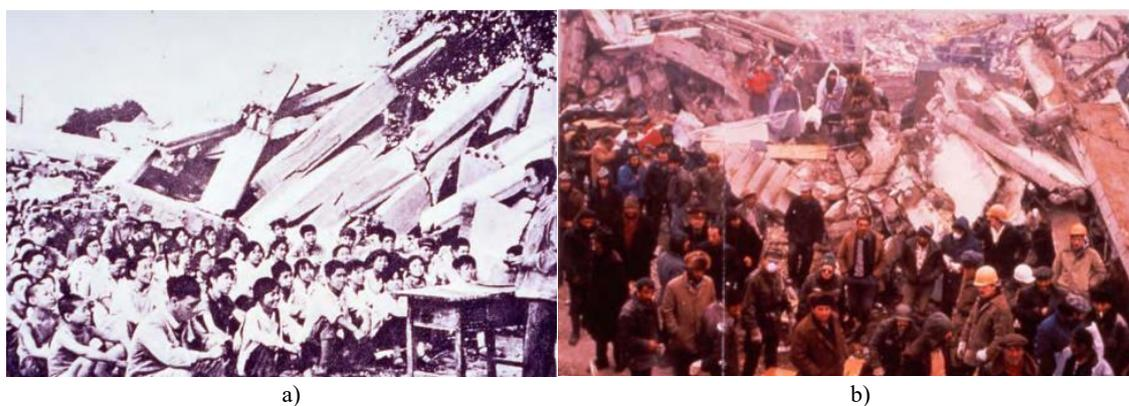
Figura 3 - a) Colapso de edifícios pré-fabricados em Tangshan, República Popular da China em 1976 [7];
