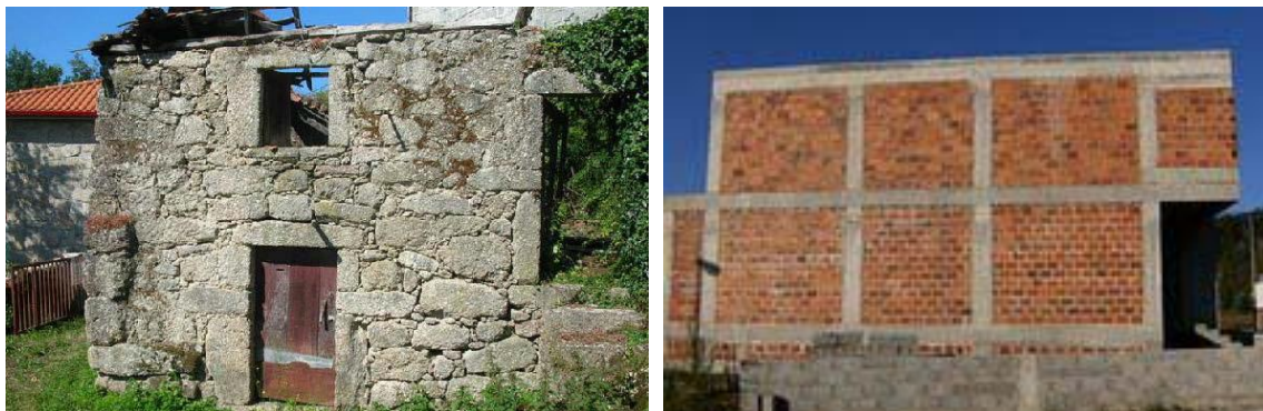
Figura 2 - Edifício com fachadas de pedra anterior a 1940 (esq.); Edifício com as fachadas de tijolo para revestimento na década de 70 (dir.) [4]
