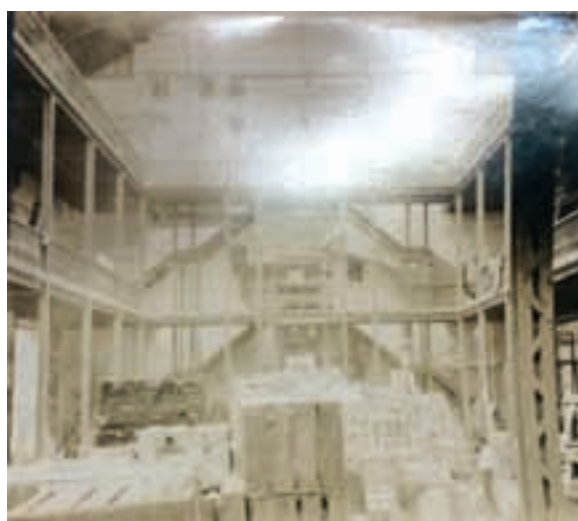
Fig. 240 – Construção do Pavilhão de Honra, 10 de fevereiro de 1923.
