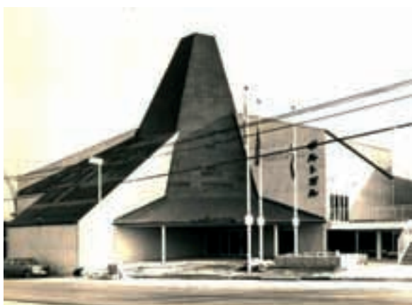
Fig. 417 – Frederico George, Pavilhão de Portugal na Exposição Universal de Osaka de 1970, fotografia da fachada principal.
