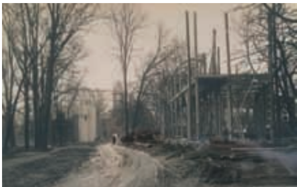
Fig. 293 – Pavilhões de Portugal na Exposição Internacional Colonial de Paris, c.1930, fotografia da construção.
