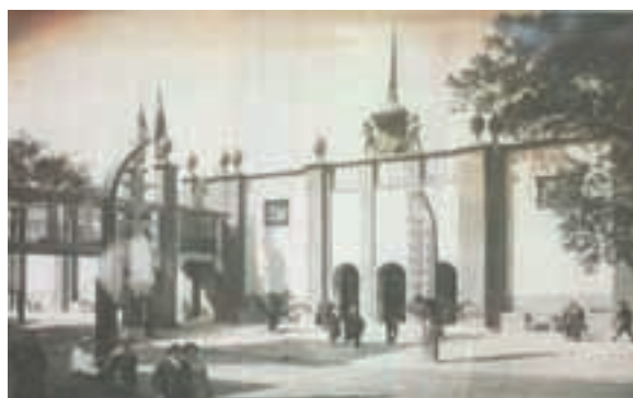
Fig. 312 – Raul Lino, fachada principal do Pavilhão B da Secção Histórica, fotografia, 1931.
