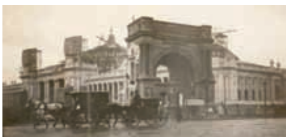
Fig. 40 – Demolição do Palácio da Indústria (1855), 1899, foto: Centre Canadien d'Architecture.
