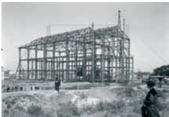
Fig. 251 – Armação do Pavilhão das Indústrias no Parque Eduardo VII, c.1931.
