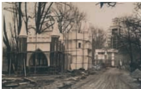
Fig. 298 – Pavilhões de Portugal na Exposição Internacional Colonial de Paris, c.1930, fotografia da construção.
