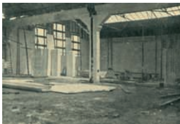
Fig. 99 – Pavilhão da secção Portuguesa, Exposição Internacional de Antuérpia de 1930, trabalhos de adaptação interior.
