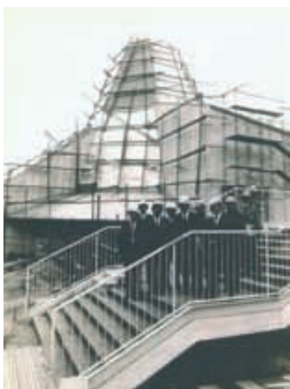
Fig. 412 – Visita de Frederico George e Daciano Costa ao estaleiro de obras do Pavilhão de Portugal na Exposição Universal de Osaka de 1970.
