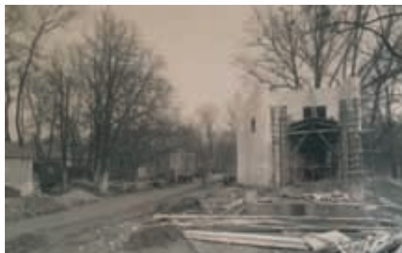
Fig. 296 – Pavilhões de Portugal na Exposição Internacional Colonial de Paris, c.1930, fotografia da construção.
