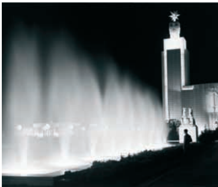
Fig. 211 – “Lago e Torre do Pavilhão dos Portugueses no Mundo”, fotografia de Mário Novais.
