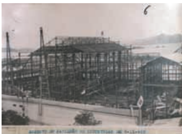
Fig. 239 – Construção do Pavilhão das Indústrias, 6 de novembro de 1922.
