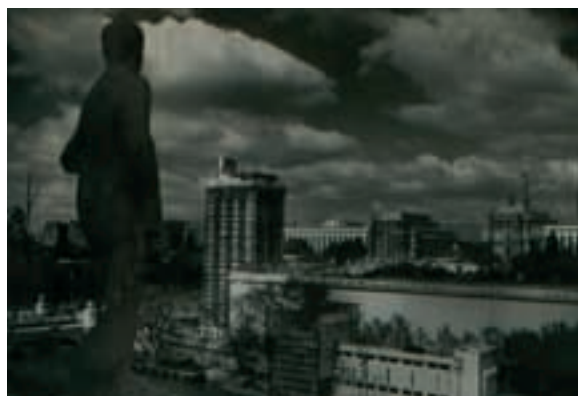
Fig. 326 – Fotografia da construção do Pavilhão de Portugal, Exposição Universal de Paris de 1937.
