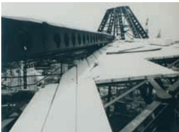
Fig. 414 – Frederico George, Pavilhão de Portugal na Exposição Universal de Osaka de 1970, fotografia da construção.
