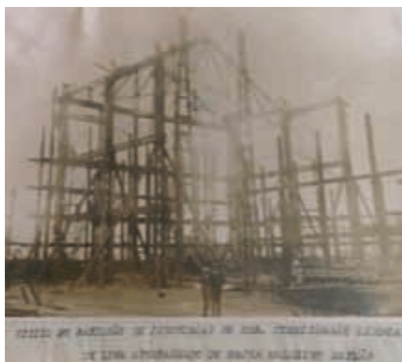
Fig. 238 – Construção do Pavilhão das Indústrias, 21 de agosto de 1922.
