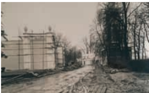
Fig. 297 – Pavilhões de Portugal na Exposição Internacional Colonial de Paris, c.1930, fotografia da construção.
