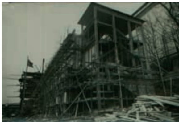
Fig. 325 – Fotografia da construção do Pavilhão de Portugal, Exposição Universal de Paris de 1937.
