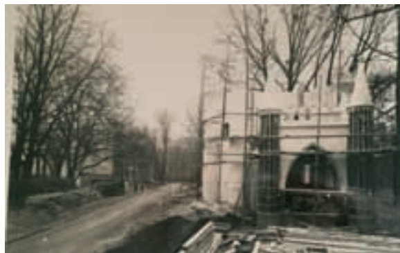
Fig. 294 – Pavilhões de Portugal na Exposição Internacional Colonial de Paris, c.1930, fotografia da construção.
