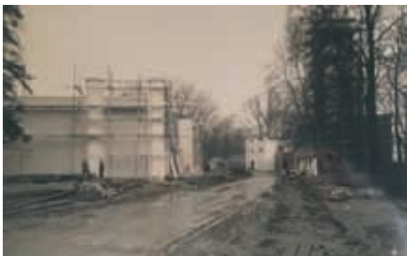
Fig. 295 – Pavilhões de Portugal na Exposição Internacional Colonial de Paris, c.1930, fotografia da construção.
