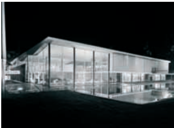
Fig. 397 – Pedro Cid, Pavilhão de Portugal na Exposição Universal de Bruxelas de 1958, vista geral, fotografia de Horácio Novais.
