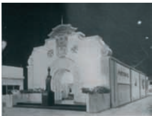
Fig. 373 – Jorge Segurado, Pavilhão de Portugal na Exposição Internacional Golden Gate de São Francisco de 1939, fachada principal do stand.
