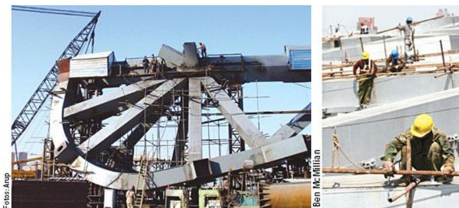
**Fig.117** – Cada pedaço que forma os 36 km de caixas metálicas ocas suporta o próprio peso, além de exercer função estrutural chave no conjunto. O anel elíptico é dividido em oito zonas de estruturas independentes.
