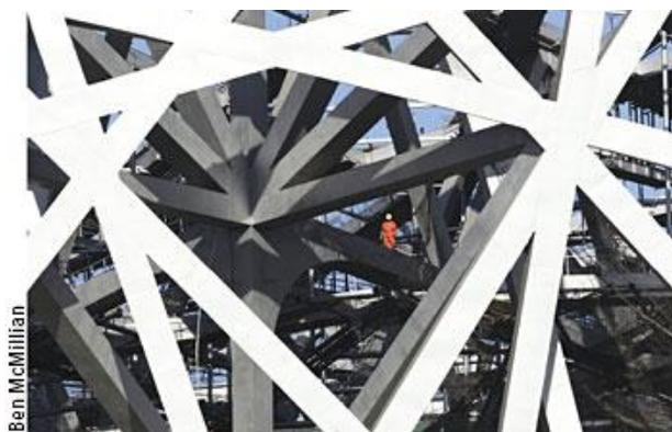
**Fig.116** – A rede metálica que envolve o anel de betão baseia-se nos padrões aleatórios da natureza (biomimetismo).
