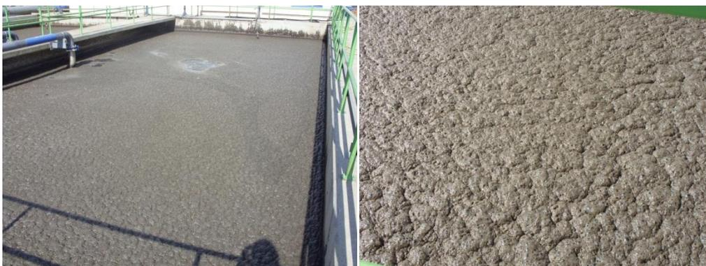
**Figura 15-** Espuma castanha presente nos tanques de arejamento.
