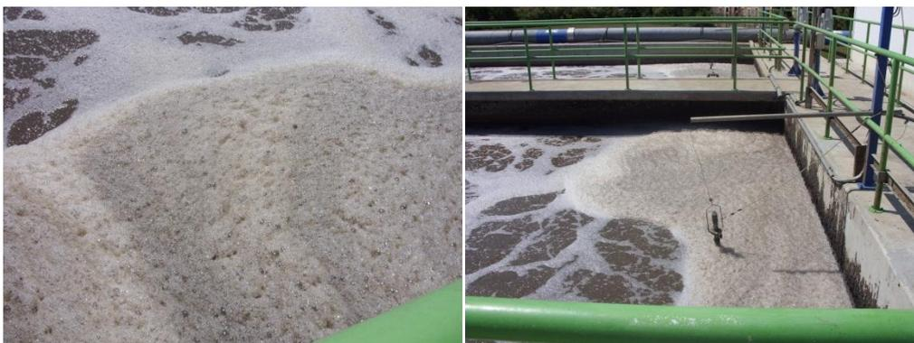
**Figura 14-** Espuma branca acastanhada presente nos tanques de arejamento.
