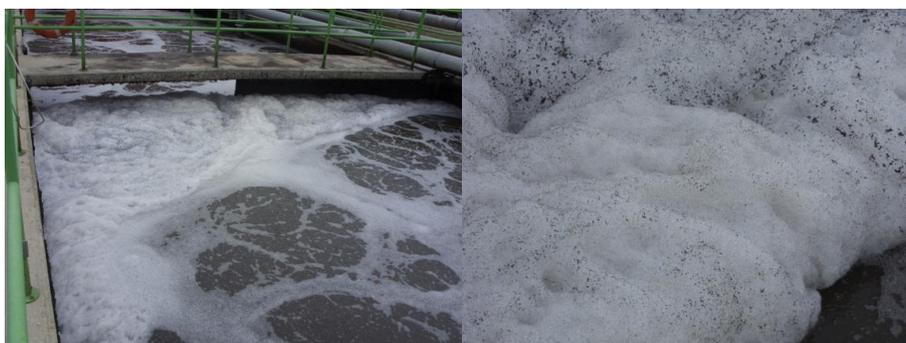
**Figura 13-** Espuma branca presente nos tanques de arejamento.
