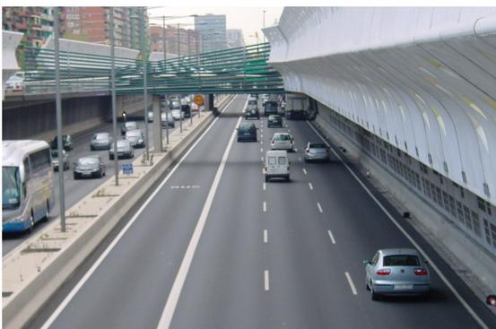
*Imagem34: As passagens pedonais, os painéis de protecção sonora com apontamentos coloridos e os elementos de iluminação, acompanham todo o percurso da via rebaixada.*
