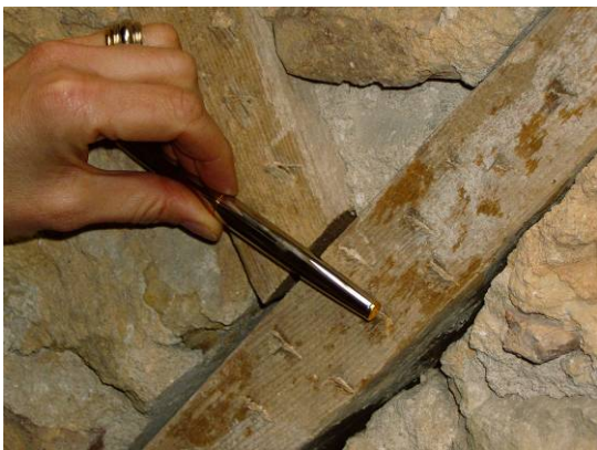
Fig. 24 - Pormenor onde se nota a relaxação que houve ao nível dos elementos resistentes
