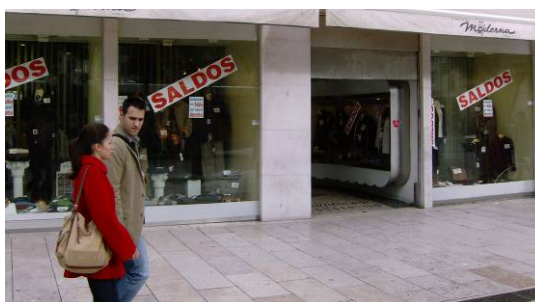
Fig. 15 - Pormenores da supressão ou diminuição da secção de pilares no piso térreo para obtenção de montras
