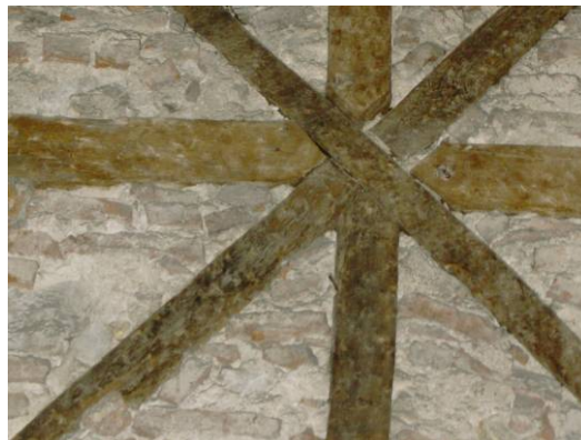
Fig. 11 - Pormenor da parede de frontal no interior do edifício
