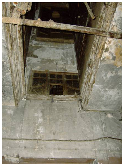
Fig. 21 - Instalação de um sistema ascensor no edifício (2)
