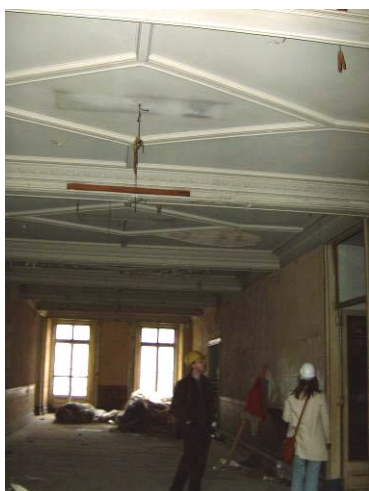
Fig. 18 – Supressão de paredes para amplificação de divisões
