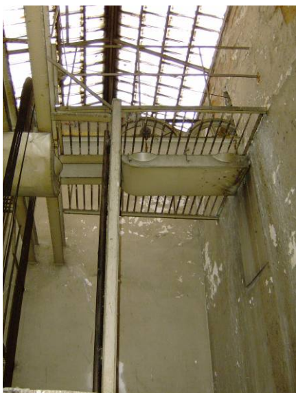
Fig. 20 - Instalação de um sistema ascensor no edifício (1)
