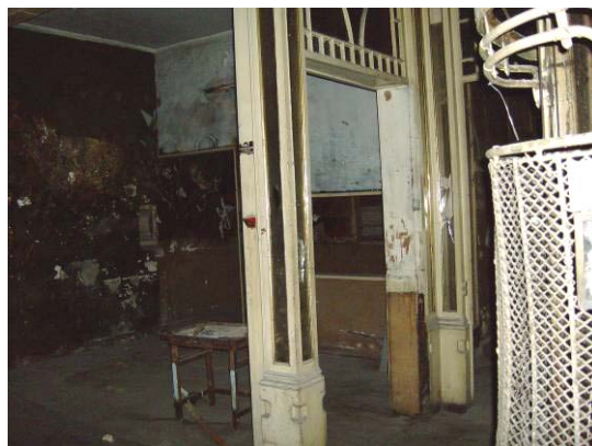
Fig. 17 – Piso superior – Vê-se claramente que houve eliminação de uma parede (no caso, frontal)
