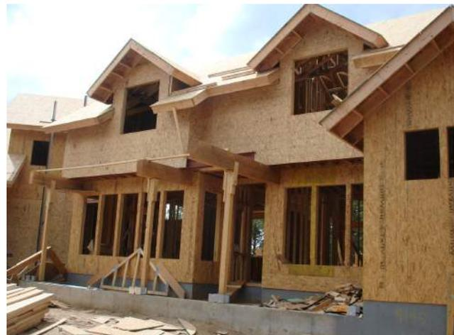
**Figura 4.29.** | Utilização de OSB como material estrutural e para revestimento de fachada.
