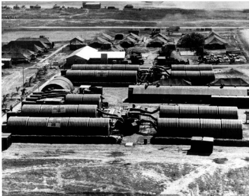
**Figura 1.5.** | Base hospitalar americana da II Guerra Mundial, erguida através das construções Nissen Hut.
