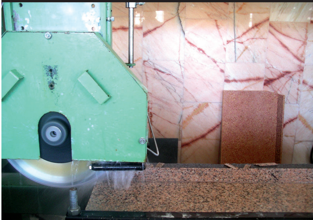
Fig. 2. Dettaglio dell'operazione di taglio del granito con un disco diamantato. Detail of granite cutting operation with a diamond disc.
