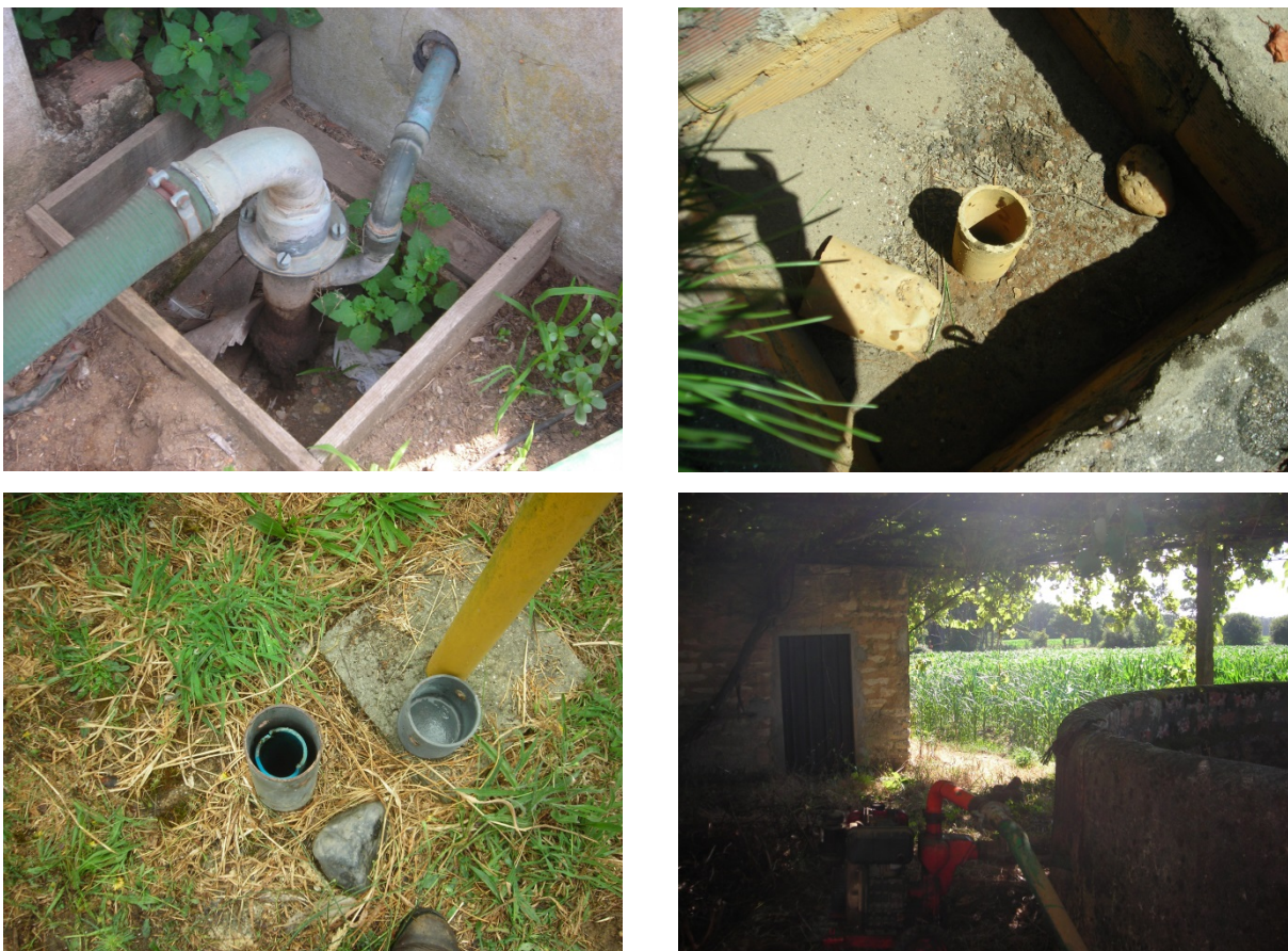
Figura 5.6- Vários tipos de captações amostradas. Da direita para a esquerda, e de cima para baixo, furo, ponta filtrante, piezómetro e poço.
