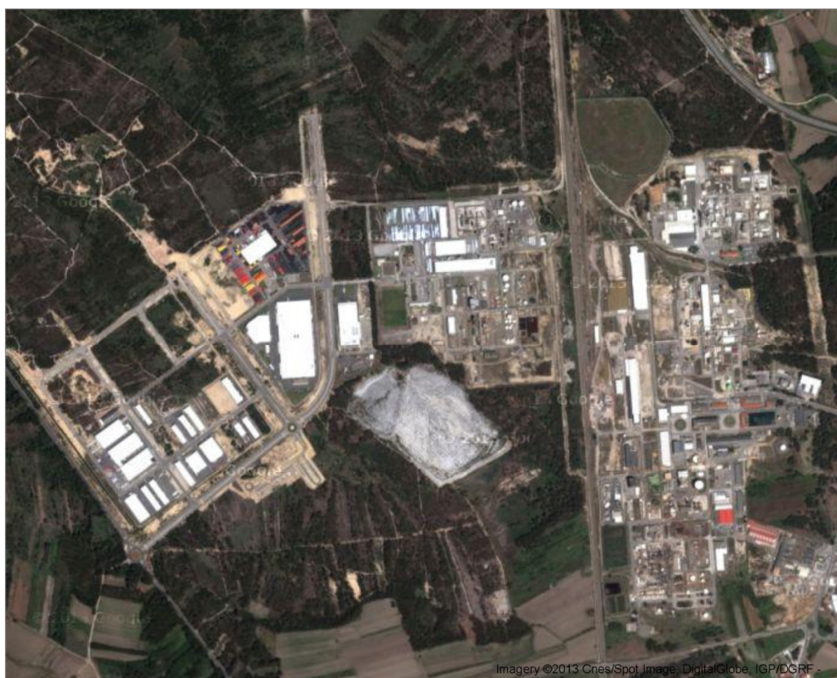
Figura 1.7- Fotografia de satélite da zona industrial de Estarreja. À direita e ao centro da fotografia encontram-se as instalações do CQE, e à esquerda, as instalações mais recentes do Eco-Parque empresarial de Estarreja. Destaca-se ainda o parque de lamas da CIRES, localizado entre o CQE e o parque empresarial, no centro da fotografia (fonte: Google Maps).
