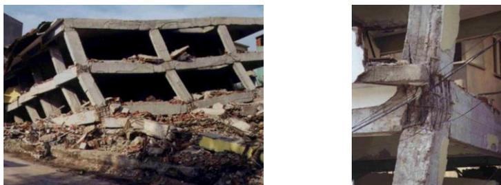
*Figura 1.1 – Rotura de ligações pilar/viga observadas no sismo de Izmit, Turquia em 1999[2]*
