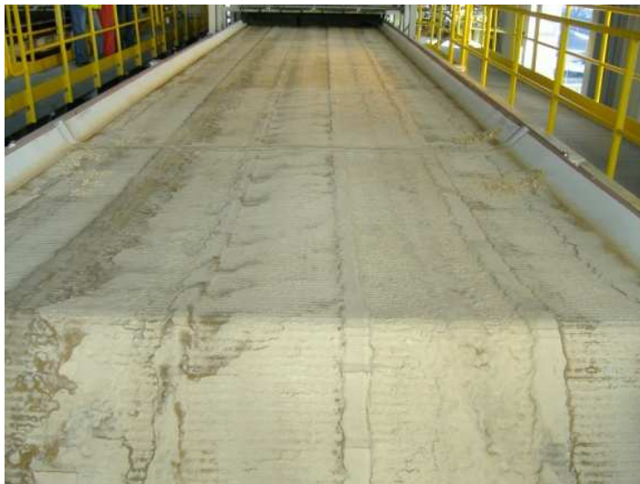
Figura 28 – Gesso à saída do sistema de absorção (Fonte: EDP, Sines)
