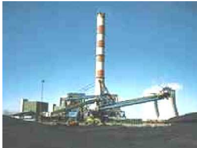
Figura 12 – Central do Pego (Foto: Tejo Energia)
