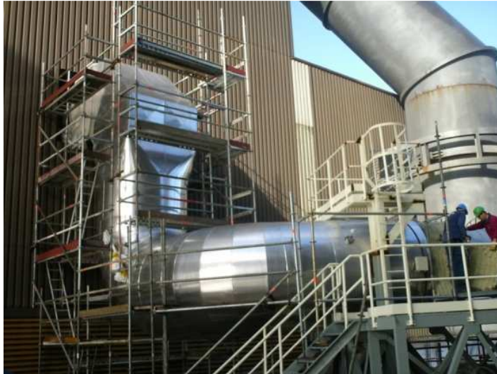
Figura 29 – Conduas BOFA (Fonte: EDP, Sines)
