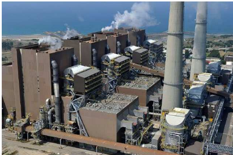
Figura 30 – Instalação SCR e FGD (Fonte: EDP, Sines)
