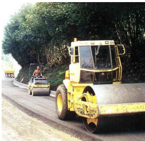
Figura 46 – Cinzas aplicadas em camada de base (Foto: ECOBA)
