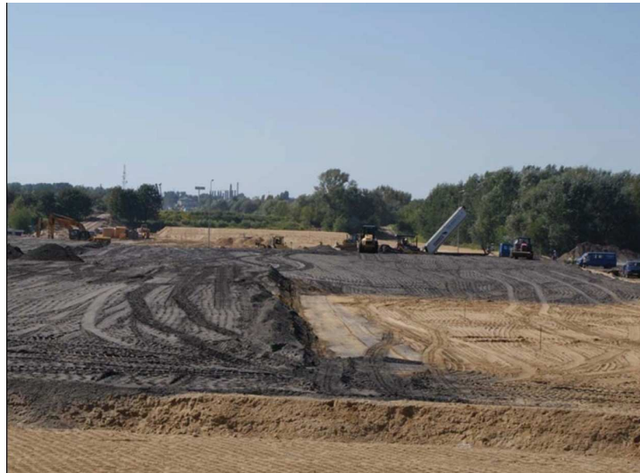
Figura 47 – Frente de obra na Polónia (Foto: ECOBA)
