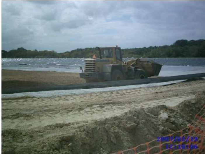
Figura 50 – Construção do aterro de gesso em Sines (Foto do autor)
