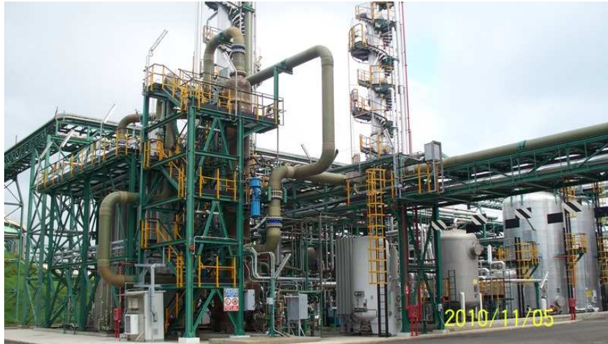
Figura 34 – Captura de CO 2 em Frederico II (Enel) (Foto do autor)
