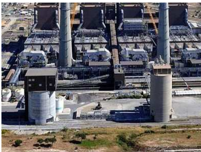
Figura 52 – Silos de gesso e cinzas para transporte ferroviário (Foto: EDP)
