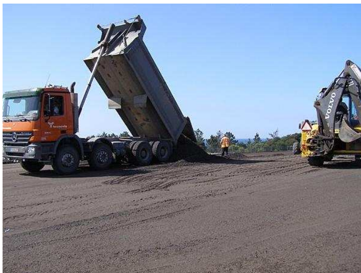
Figura 49 – Colocação do material em obra (Foto: EDP)
