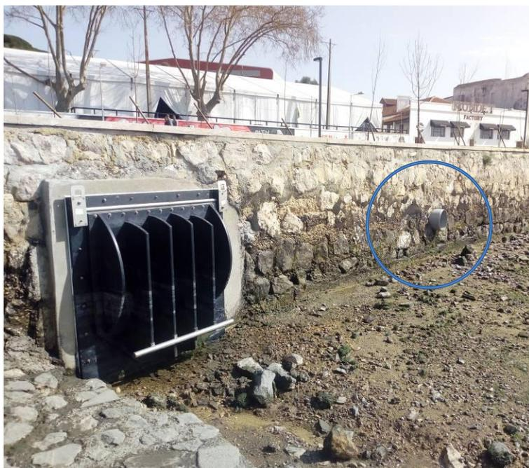
**Fig. 208:** Capleta antirretorno de fim-de-linha, colocada no final do pluvial do Seixal que vem da Mundet (a uma cota mais elevada) (2018).
