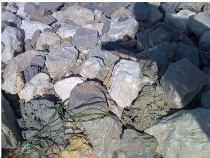
**Fig. 158:** Fotografia do material de enrocamento colocado em fase de obra na Frente Ribeirinha da Arrentela-Seixal e Fidalga e que foi alvo de várias reclamações por parte da equipa de fiscalização.
