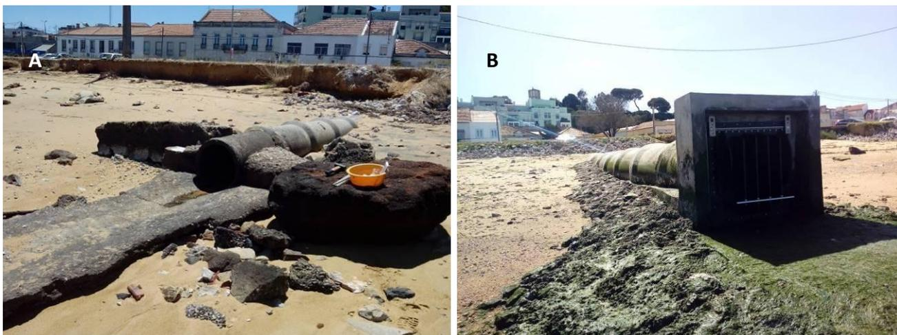
Fig. 209: Foto de pluvial sem campânula de maré (5/8/2015) (A) e foto atual (2019) (B).
