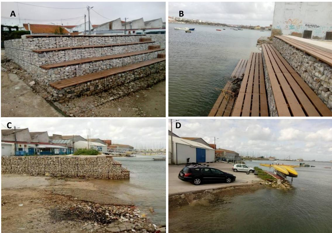
**Fig. 196:** Fotografias da estrutura de defesa aderente (A), que elevou a cota de coroamento, comparativamente à zona não intervencionada (D), em preia-mar de maré viva quase equinocial de 2018/03/01 (B, C, D).
