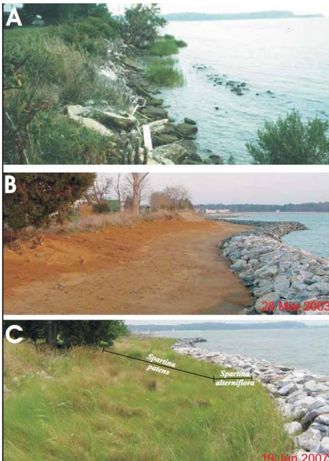
**Fig. 43:** Evolução bem sucedida da técnica de barreira de pedras, deposição de areia em rampa de 10:1 ou 10% de inclinação e plantação de *Spartina* sp. na costa Oeste da Virgínia (Hardaway *et al.*, 2010)
