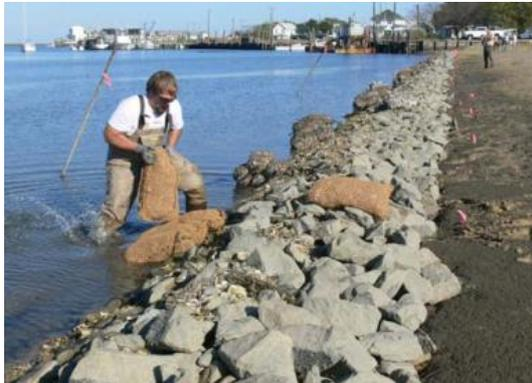
**Fig. 42:** deposição de barreira de pedras ao longo da linha de costa, na zona inter-tidal; note-se a deposição de alguns sacos com ostras (VEEWCS, 2011).
