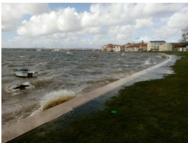
**Fig. 211:** Galgamento da muralha em dia de preia-mar de maré viva e equinócial, com vento forte (2018/03/01).
