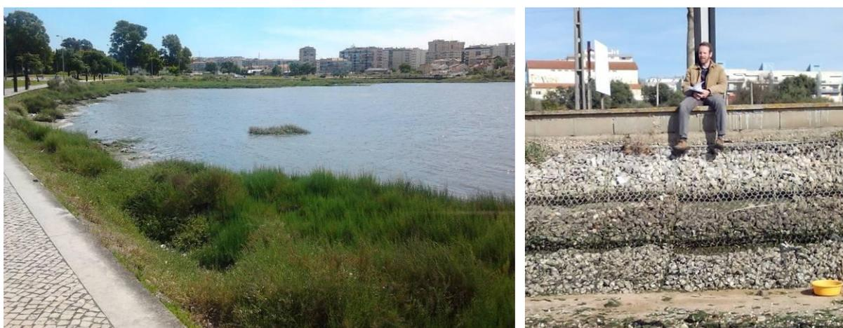
**Fig. 40 e 41:** Crescimento espontâneo de sapal na Baía do Seixal por sedimentação natural, protegendo as estruturas construídas da erosão costeira (colchões *Reno*), que mais a Norte, sem a proteção do sapal se encontram em mau estado de conservação (Maio de 2014 e 2015 respetivamente).
