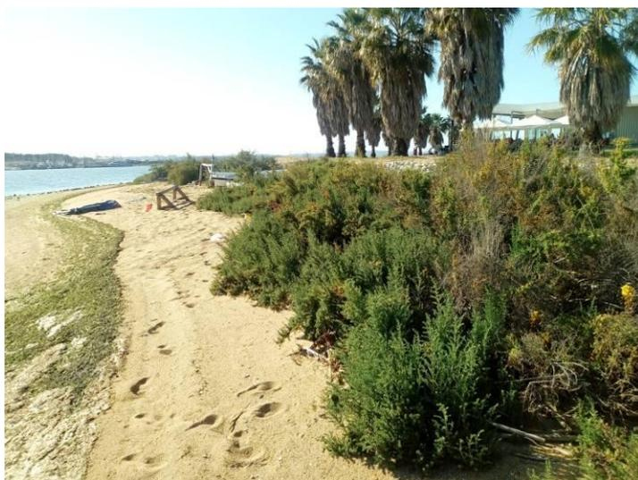
**Fig. 133:** Fotografia da solução de defesa costeira híbrida com areia+sapal+faixa de enrocamento+areia, executada em 2005, na obra da Quinta da Fidalga, passeio ribeirinho do Seixal.
