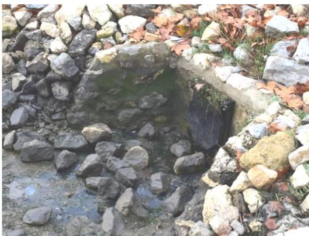
**Fig. 175:** Fotografia atual do efluente de pluviais com "capleta antirretorno de fim de linha" na Frente Ribeirinha da Amora, perto do E. LeClerc.
