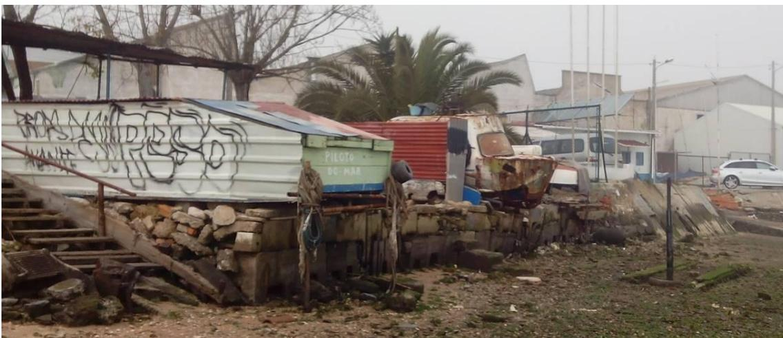
**Fig. 172:** Fotografia da proteção existente em entulho dentro de tanques de lavar louça empilhados (14/11/2016).
