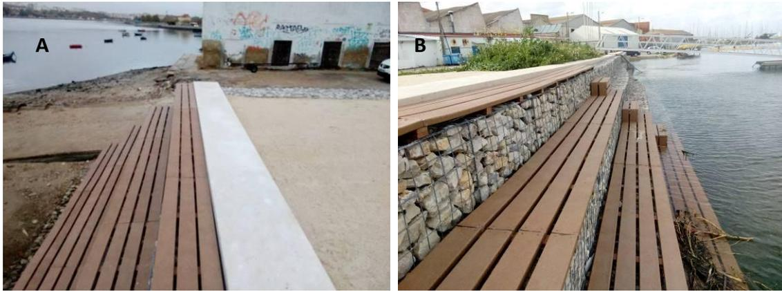
**Fig. 195:** Fotografias da estrutura de defesa aderente, na zona de deck em compósito, cobertores de 40 para 60 cm, em baixa-mar (2017/10/19) (A) e preia-mar de maré viva quase equinocial (2018/03/01) (B).
