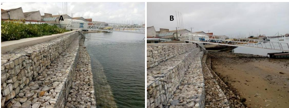
**Fig. 193:** Fotografias da estrutura de defesa aderente, na zona de “abertura” dos cobertores para de 40 para 60 cm, em preia-mar de maré viva quase equinocial (2018/03/01) (A) e baixa-mar (2017/10/19) (B).
