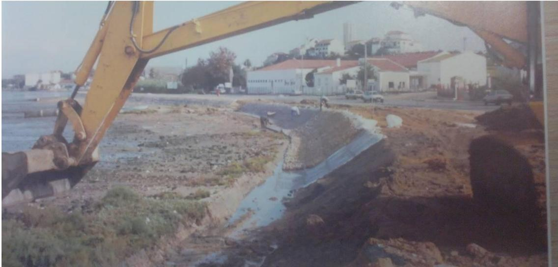
**Fig. 163:** Fotografia da construção do paredão da Arrentela (14-10-93, fotografia do arquivo da CMS), note-se que foi posto um geotêxtil por debaixo dos colchões *Reno* e que estes reduzem a camada de enrocamento à espessura dos próprios colchões (cerca de 40 cm).
