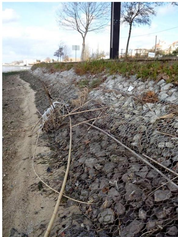
**Fig. 162:** Fotografia atual da “muralha” feita em 1993 com colchões *Reno*, com declive muito acentuado, na ligação ao paredão de calcário.
