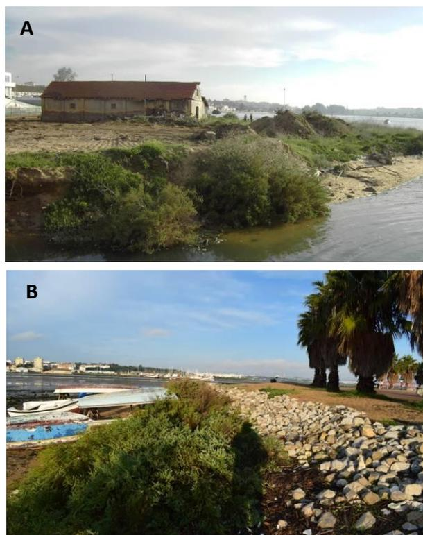
**Fig. 167:** Fotografias do Estaleiro da Fidalga em 2004, no início das obras (A) e atualmente (B), após a obra de intervenção de 2005 (enrocamento de 1 m de espessura com geotêxtil + areia + transplante de sapal).
