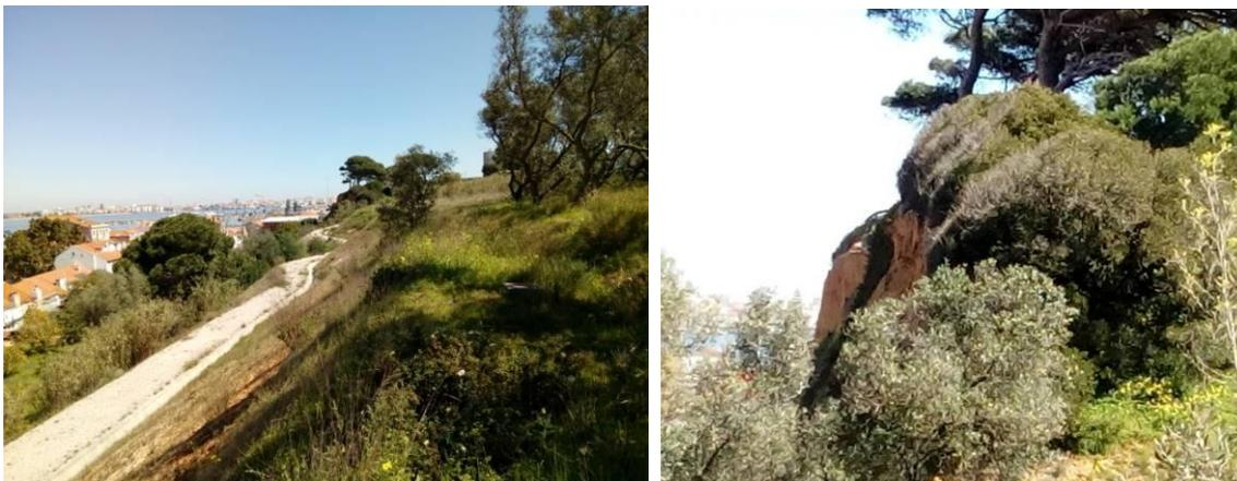
**Fig. 110 e 111:** Talude resultante da “estabilização” da arriba por detrás da povoação do Seixal, onde se avista a antiga arriba que não foi intervencionada, pormenorizada na segunda fotografia, em perfil (Outubro de 2018).
