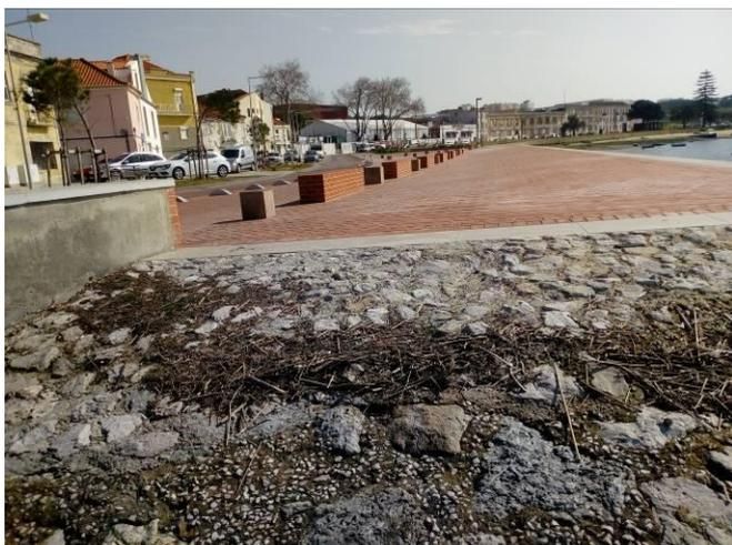
**Fig. 206:** Fotografia da rampa NW, junto à “curva da Timbre” num dia calmo, onde se vê até onde cegou a preia-mar e que existe um ponto mais baixo da rampa junto ao murete, que não está de acordo com o projeto.
