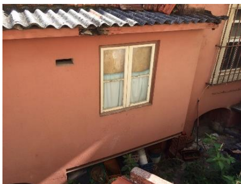
Figura 17 - Corpo balançado no tardoz do edifício (Por Appleton & Domingos Arquitetos)
