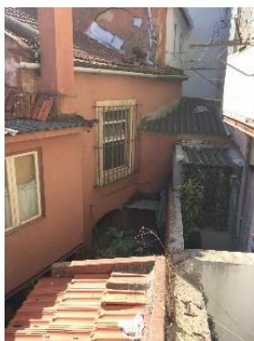
Figura 16 - Vãos assimétricos e com diferentes materialidades para o saguão (Por Appleton & Domingos Arquitetos)
