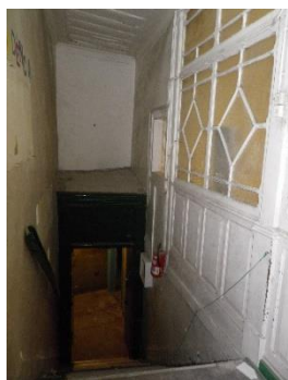
Figura 23 - Vista do segundo lanço de escadas com vista para o patamar intermédio (Por Appleton & Domingos Arquitectos)
