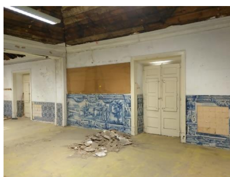
Figura 30 - Salão com masseira que preenche o gaveto do piso 2 (Por Appleton & Domingos Arquitetos)
