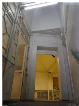
Figura 24 - Último patamar como zona de distribuição do piso 2 (Por Appleton & Domingos Arquitectos)
