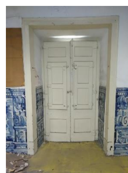
Figura 31 - Portadas em madeira que pontuam muitos dos vãos do segundo piso (Por Appleton & Domingos Arquitetos)
