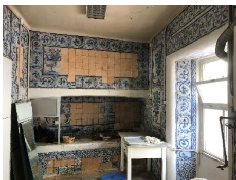
Figura 29 - Cozinha do segundo totalmente forrada por azulejos (Por Appleton & Domingos Arquitetos)
