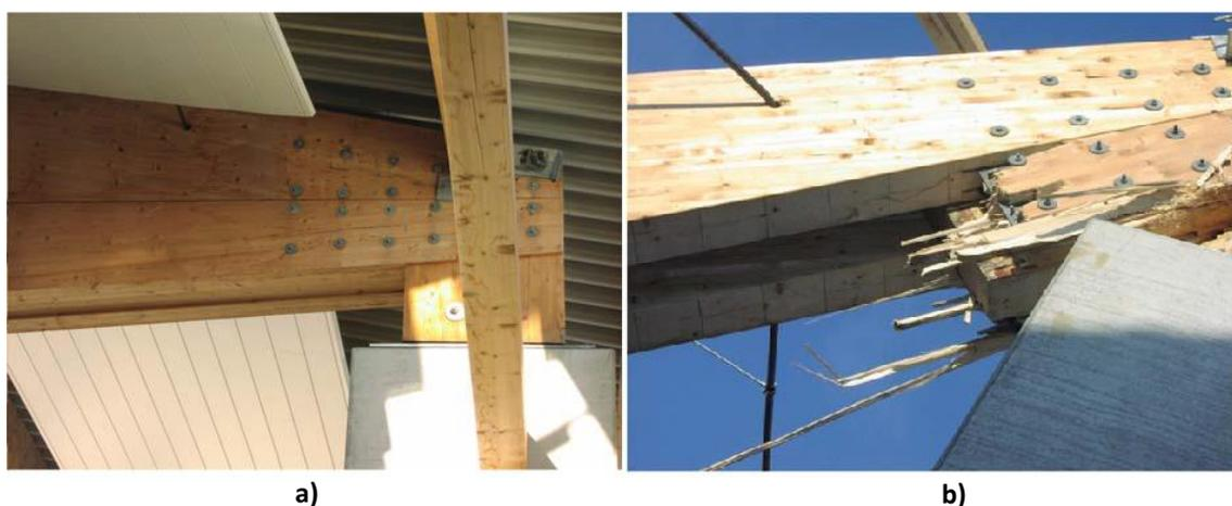
Figura 4.14 - Colapso de uma ligação [adaptado de Kliger, 2013]
