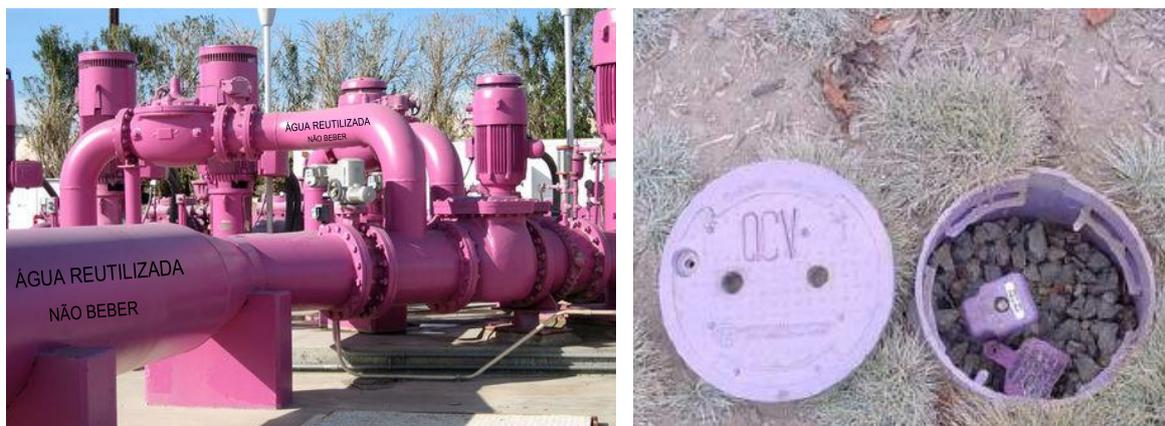
**Figura 3.1 - Exemplo de identificação de redes de distribuição de água reciclada [fonte: WateReuse Association]**
