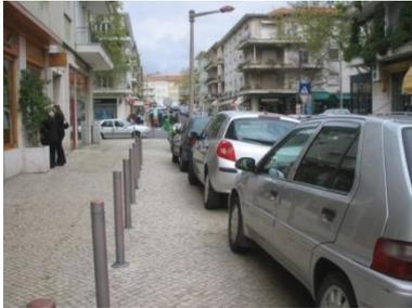
Figura 13 - Exemplo de má colocação de pilaretes.
