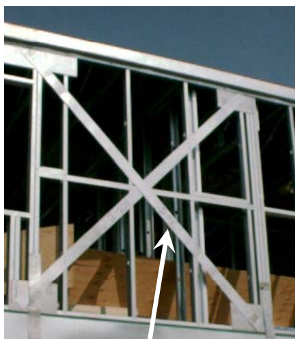
Figura 2.46 - Exemplo de contraventamento X-bracing .
