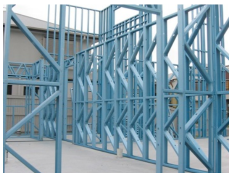
Figura 2.45 - Exemplo de contraventamento K-bracing .
