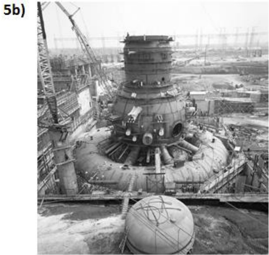
Figura 5: 5a) Contenção Mark I (figura retirada da referência [8]); 5b) Fotografia do reator de Browns Ferry (EUA) em que se vê explicitamente o vaso do reator e a câmara de supressão (figura retirada da referência [11])
