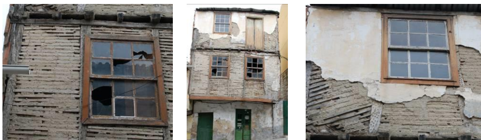
Fig. 124 - Fasquiados e vigas de pavimento visíveis nas fachadas de edifícios de resalto em Chaves (Fotos autor).
