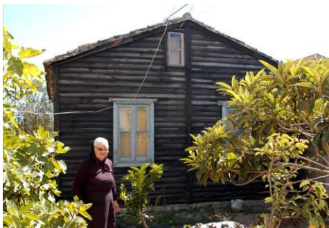
Fig. 130 - Palheiro de Mira num logradouro revestido com tábuas costaneiras na horizontal (Foto autor).
