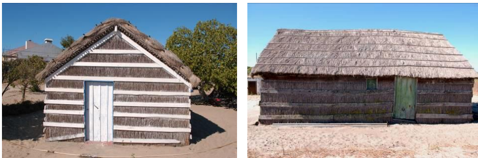
Fig. 137 - Cabanas na Carrasqueira com as tábuas costaneiras horizontais para fixação do caniço (Fotos autor).
