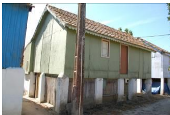
Fig. 141 - Habitações na Palhota com revestimento em painéis de contraplacado (Fotos autor).
