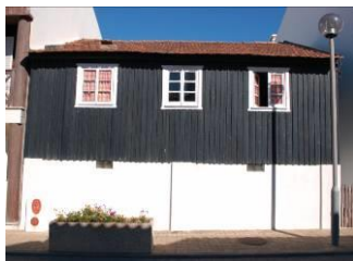
Fig. 132 - Palheiros da Tocha com o piso inferior em alvenaria e o revestimento em tabuado vertical (Foto autor).
