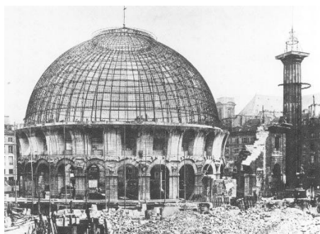
Fig. 8 - Halle au Blé, Paris (1808-13) - Fotografia obtida durante os trabalhos de reconstrução da cúpula (Addis, 2007).
