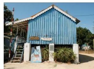
Fig. 142 - Habitação na Palhota com tabuado vertical (Foto autor).
