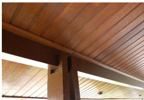
Fig. 173 - Pormenor de encontro de um pilar com uma viga (Foto autor).
