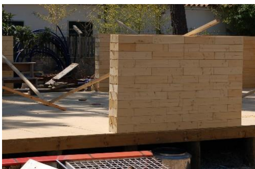
Fig. 174 - Construção de uma casa com blocos de madeira pela empresa Empatias (Foto autor).
