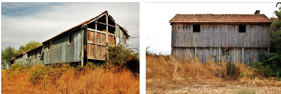
Fig. 138 - Cabanas no Patacão de Cima, Alpiarça, com uma estrutura híbrida entre o porticado e o reticulado (Fotos autor).
