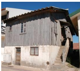
Fig. 132 - Palheiros da Tocha com o piso inferior em alvenaria e o revestimento em tabuado vertical (Foto autor).
