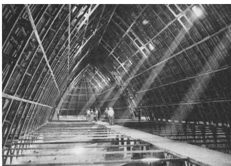
Fig. 7 - Catedral de Chartres, Chartres (1194-1260) - Estrutura da cobertura em ferro forjado executada em 1837 (Addis, 2007).
