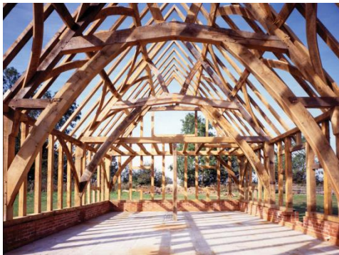
Fig. 247 - Estrutura de porticado "Green-Oak", juntas típicas e efeitos do assentamento da madeira (Roos, Metten, & Holloway, 2007).
