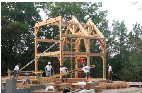
Fig. 245 - Montagem de uma habitação "Timber-frame" (Riverbend Timber Framing, 2015).
