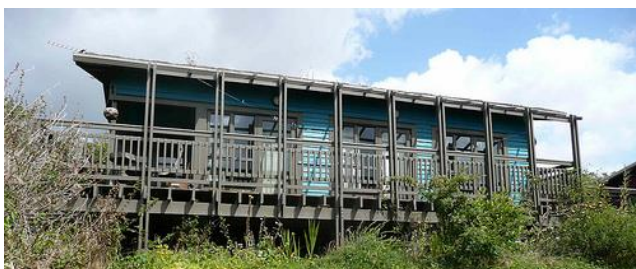
Fig. 249 - Uma habitação auto-construída Segundo o método Segal em Brighton ( http://www.selfbuild-central.co.uk/construction/main-structure/post-and-beam/ ).
