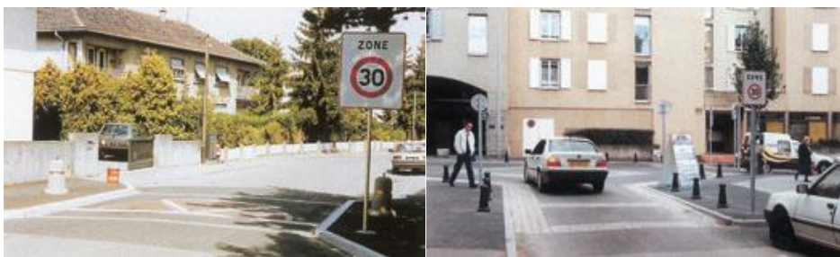
Figura 3.25 - Exemplos de medidas de acalmia de tráfego a utilizar nas entradas das “Zonas 30” (fonte: CERTU, 1995)
