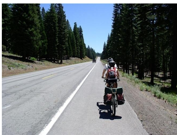
Figura 3.2 – Exemplo de berma pavimentada de forma a permitir a circulação de bicicletas (fonte: Austroads, 1999)
