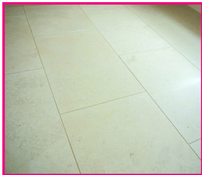
Fig.3 Esempio di limestone Moleanos usato per pavimentazione An example of typical use of Moleanos limestone in flooring
