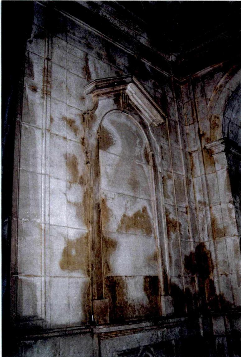
Fig.107 - Pormenor de uma das paredes da galilé, onde são visíveis manchas associadas a diferentes teores de humidade das paredes.
