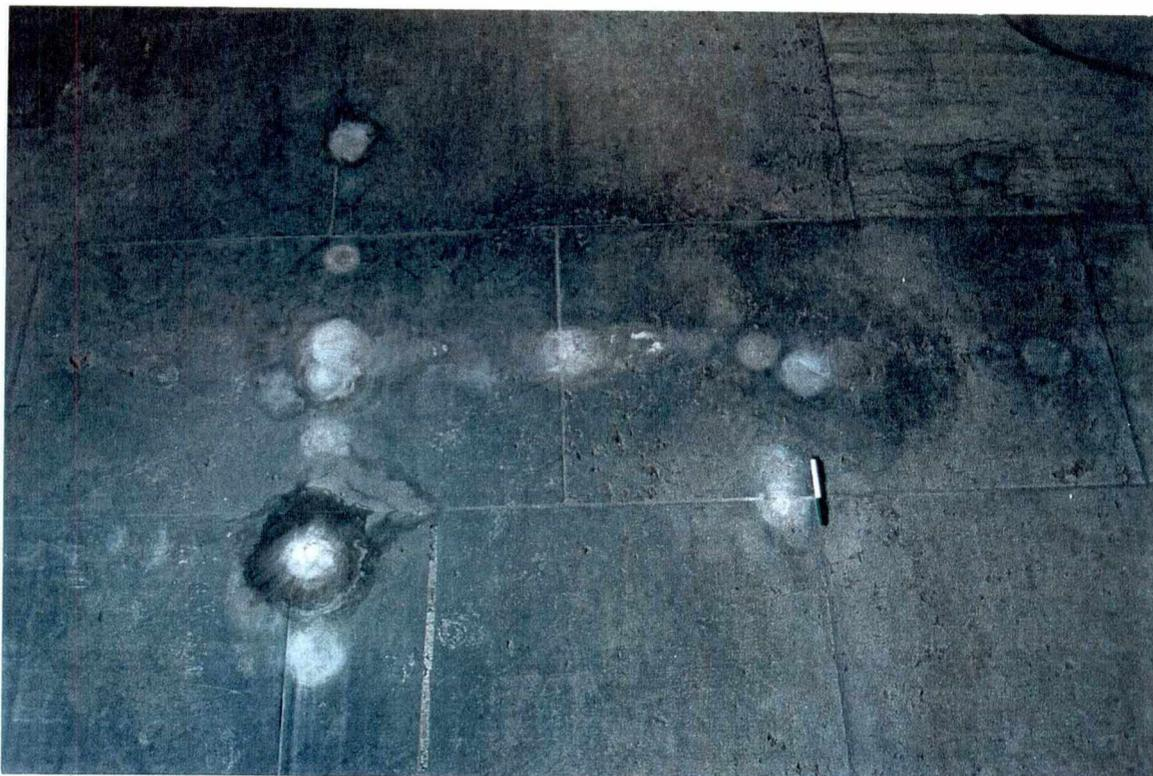
Fig.103 - Concreções no chão do coro alto. São também comuns no chão da igreja (transepto e nave). Resultado, sobretudo, da lixiviação das juntas pelas águas de infiltração.
