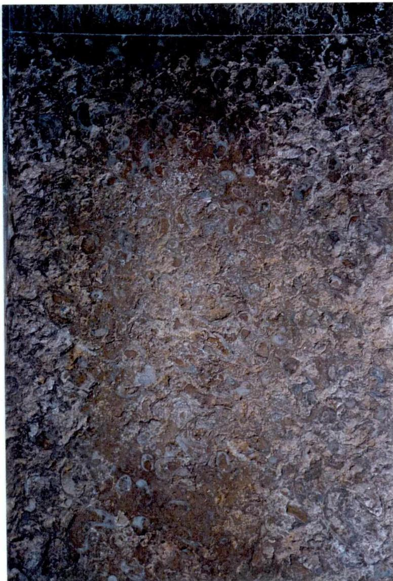
Fig.101 - Pormenor do estado de desagregação do painel anterior em Amarelo de Negrais. Segunda placa a contar de baixo.
