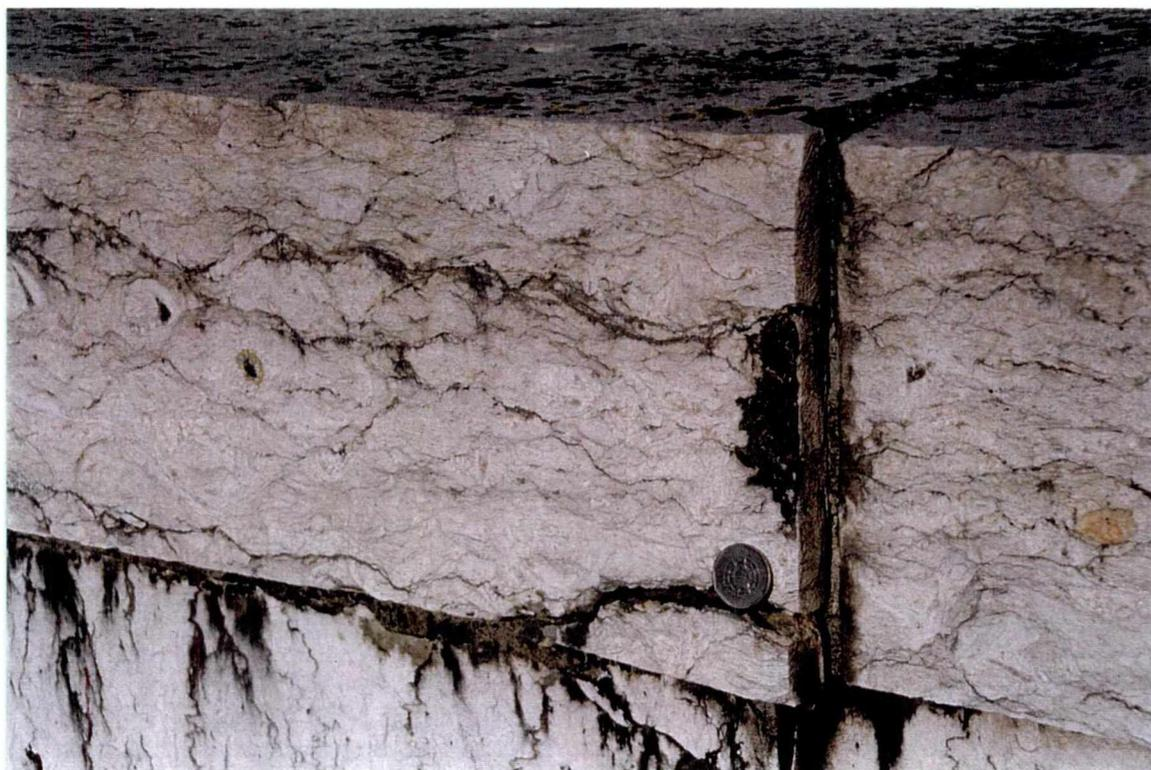
Fig.98 - Fracturas e estilolitos abertos no Lioz da balaustrada do Terraço.
