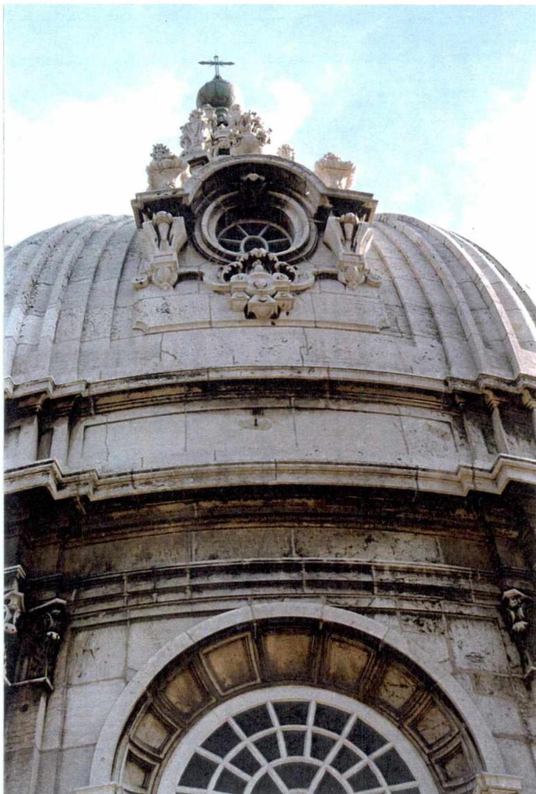
Fig.99 - Pormenor da cúpula do zimbório, onde são visíveis sujidades de cor negra acastanhada, em zonas suficientemente protegidas da accção das águas pluviais.
