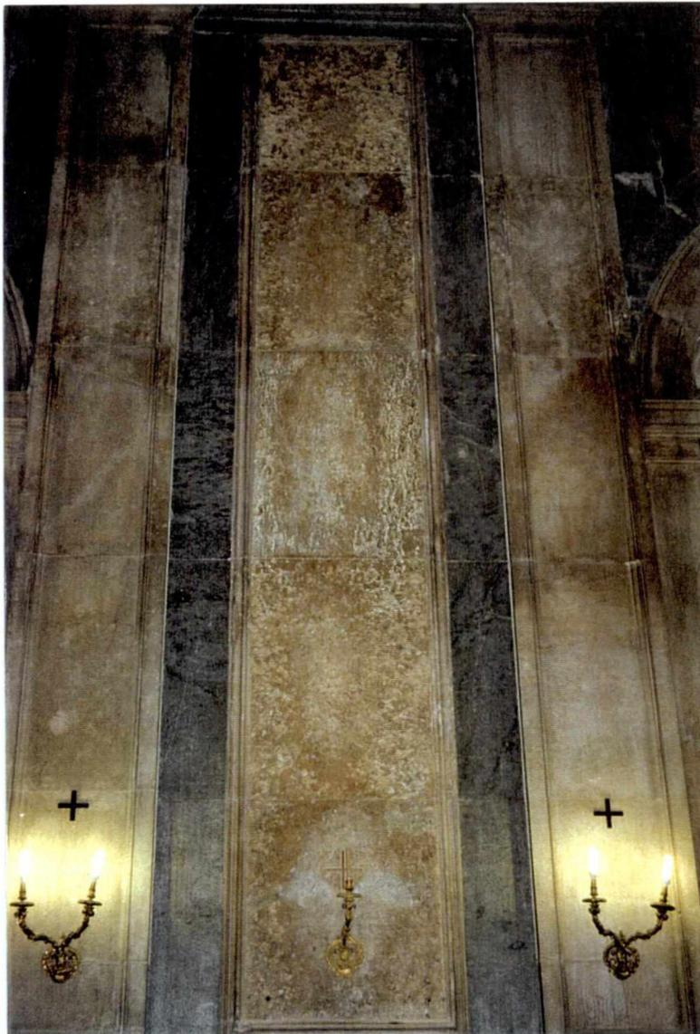
Fig.2 - Aspecto geral dos painéis em Amarelo de Negrais, estudados no interior da Basílica. Ilustra-se, também, o seu comportamento diferenciado face à envolvente microclimática.
