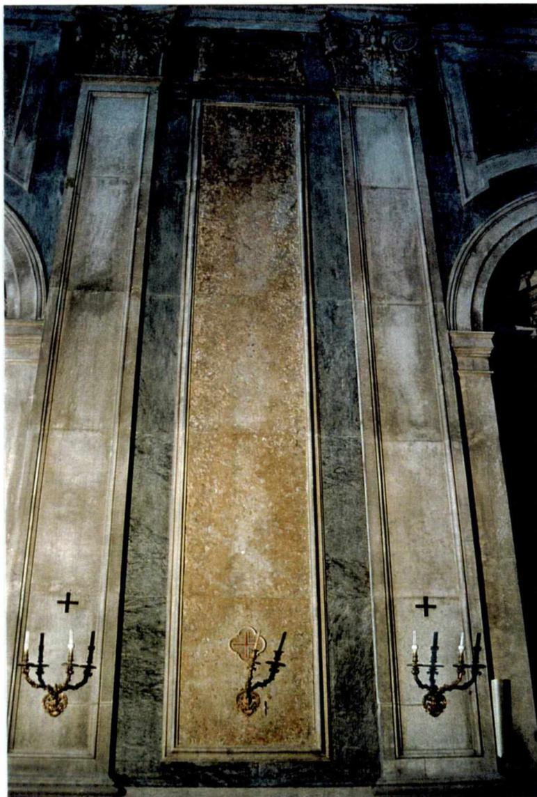
Fig.104 - Aspecto geral da parede do lado direito do altar de S. José. Notar as largas manchas esbranquiçadas de calcite reprecipitada sobre o Lioz e o Amarelo de Negrais.
