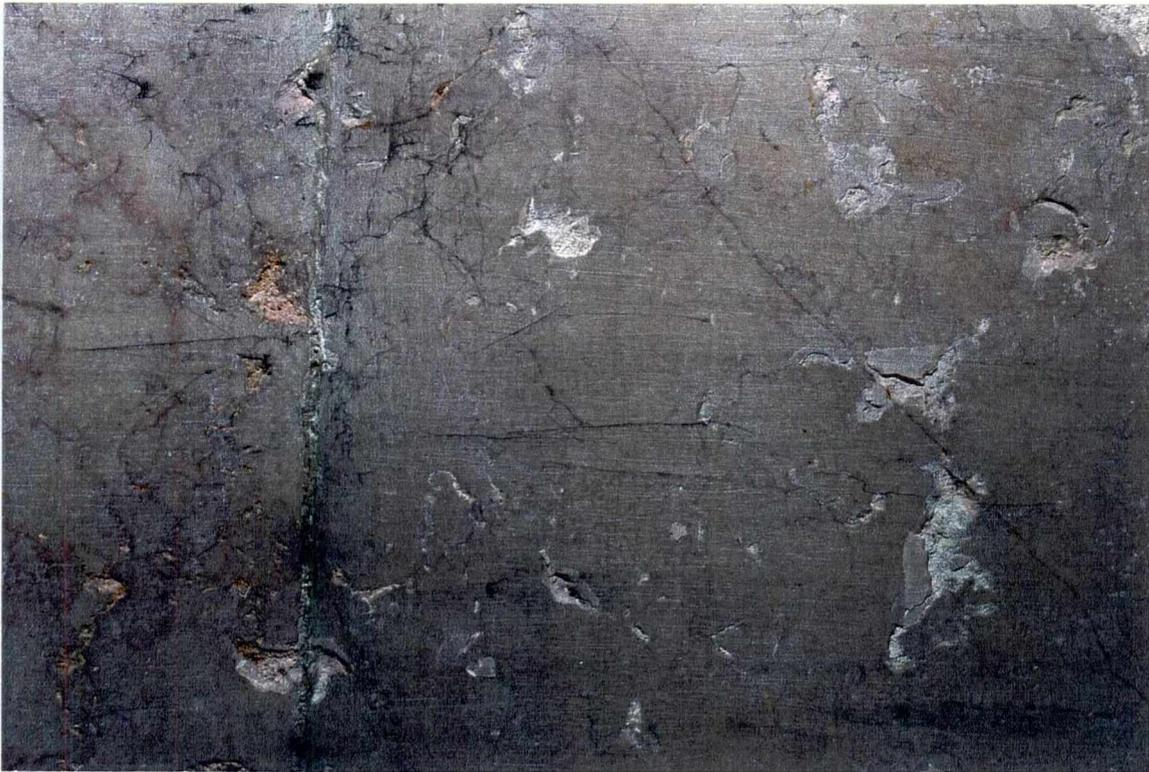
Fig.102 - Pormenor de uma das paredes da sala de monitorização dos poluentes atmosféricos (Coro alto). É visível o "destacamento" de pequenas lascas (escamas) do calcário de revestimento.
