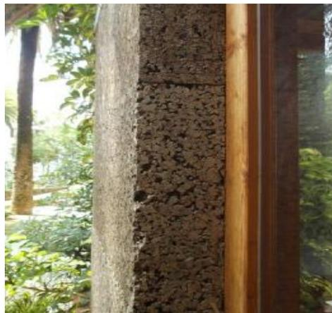
Figura 3.33: Falta de material nas placas do aglomerado expandido de cortiça [11].
