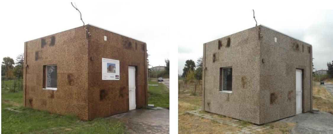
Figura 3.34: Diferentes tonalidades do revestimento exterior [11].
