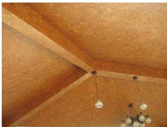
Figura 4.27: Revestimento de tecto com uma textura de Oak wood com um acabamento envernizado [S18].
