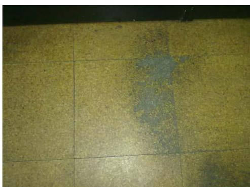
Figura 3.15: Sinais de desgaste superficial do revestimento de aglomerado de cortiça [19].
