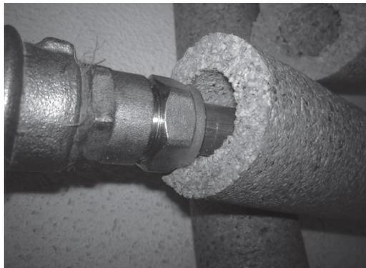
Figura 3.38: Revestimento tubular flexível de cortiça [6].
