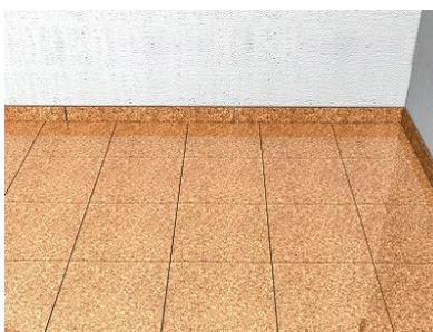
Figura 3.11: Pavimento de cortiça em forma de placas [S4].
