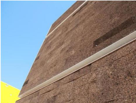
Figura 5.12: Destacamento das placas na fachada [14].
