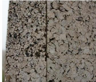
Figura 5.16: Diferenças de tonalidade e rugosidade do revestimento [14].
