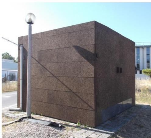
Figura 3.31: Célula experimental com placas de aglomerado de cortiça aplicado [11].
