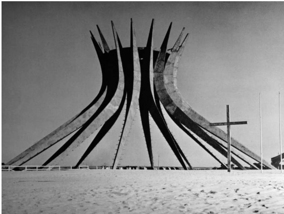
Fig. 103 – Estrutura ainda sem os vidros aplicados
