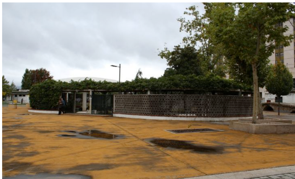
Fig. 201 – vista geral do edifício
