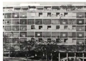
Fig. 10 – Fachada de um dos edifícios do conjunto do Parque Guinle com cobogós e brise-soleil (Lúcio Costa)
