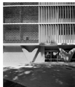
Fig. 26 – Cobogós e Brise-Soleil na fachada do Hospital Sul América, Rio de Janeiro, Brasil (Oscar Niemeyer)
