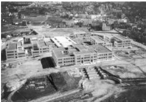
Fig. 137 – Vista aérea sobre o campus do Instituto Superior Técnico em construção, 1934
