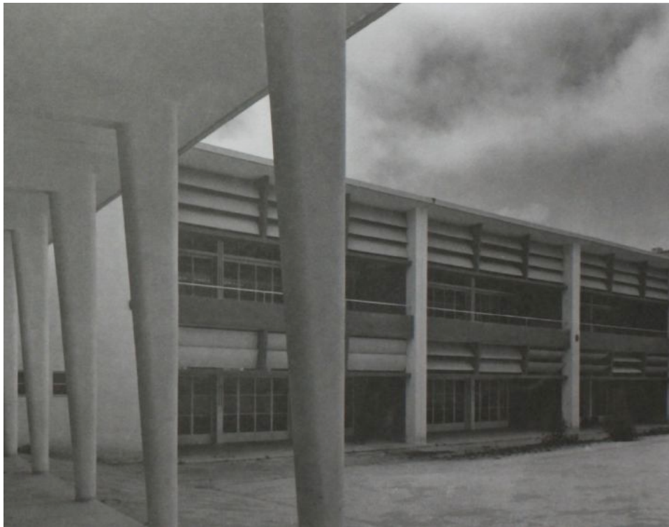
Fig. 184 – pilares e brise-soleil móveis nas salas de aula
