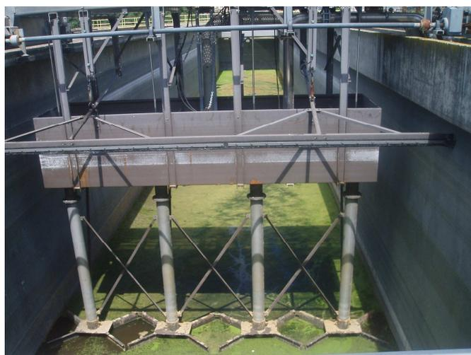
**Figura 17 – Ponte raspadora – pormenor do caixaõ e dos tubos de sucção.**
