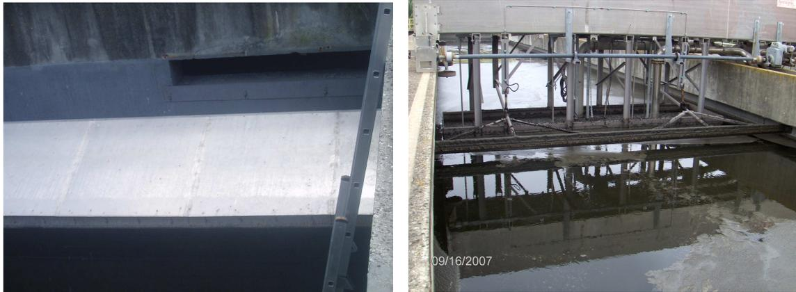
**Figuras 14 e 15 – Pormenor da saída dos flutuantes (Fig.14) e do skimmer na posição “stand-by” (Fig.15)**
