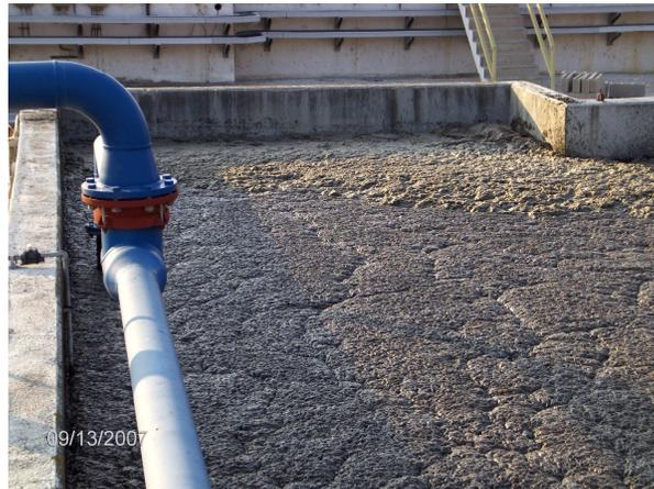
**Figura 11 – Presença de espumas no tanque de arejamento 5**
