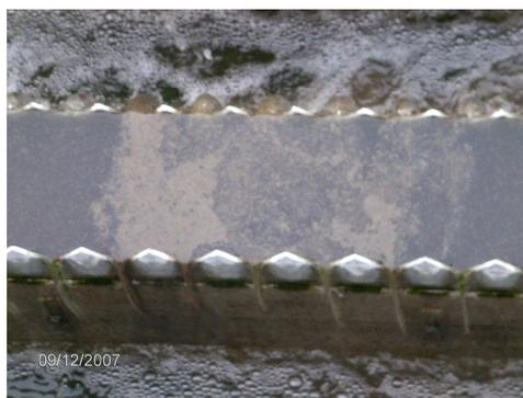
**Figura 38 – Arrastamento parcial do manto de lamas (clarificado carregado de lamas)**
